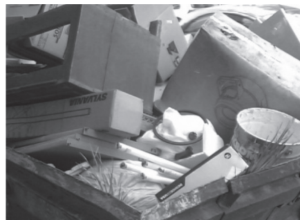
Figura 2: Contenedor de obra con RCD contaminantes.
