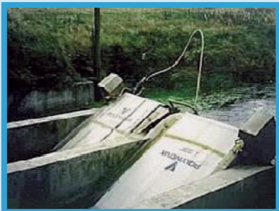
FIGURA 3.13. Filtro de banda.
