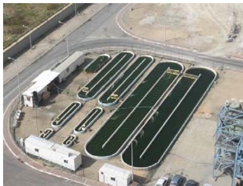
Figura 3. Una industria sostenible. La empresa israelí Seabiotic tiene en uso una planta piloto para el consumo de CO 2 procedente directamente de las chimeneas de una fábrica de electricidad de la Israeli Electric Company . El alga, del género Nannochloropsis , produce un 30% de lípidos por gramo de biomasa y se emplea para la producción de biodiesel. La fotografía muestra como el gas carbónico sale de la industria por un conducto (esquina inferior derecha) que está conectado directamente a los biorreactores abiertos de agua salada donde crece el alga, que se recoge posteriormente para su procesamiento. Imagen cedida por Ami Ben-Amot.
