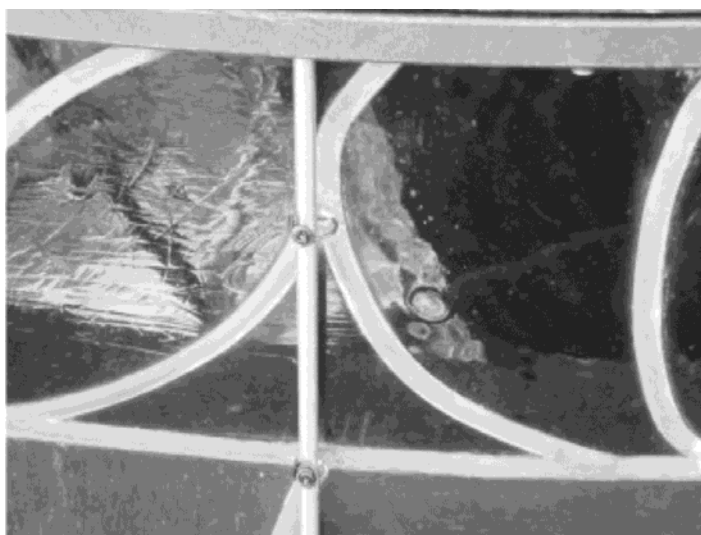
Figura 16. Imagen de un panel de vidriera restaurada y reinstalada, con ataduras de hilo de cobre lacado.
