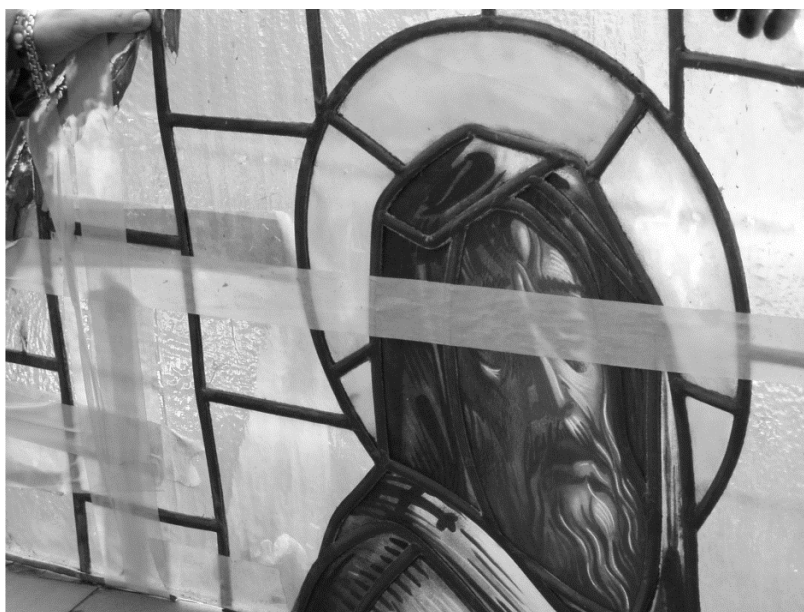
Figura 13. Imagen de un panel de vidriera encintado para su transporte.
