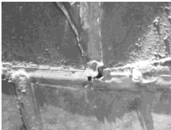
Figura 15. Imagen de un panel de vidriera con rotura en la soldadura del emplomado.
