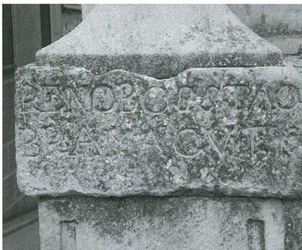
Figura 1. Piedra monumental de la Iglesia de San Justo y Pastor (Segovia) con signos de biodeterioro y una colonización visible por líquenes.
