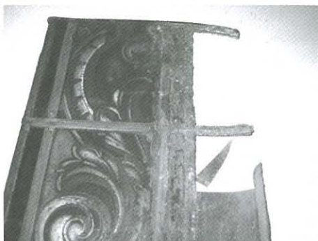
Figura 11. Fragmento de una vidriera de la Casa Goyeneche de Madrid. Se observan roturas en los vidrios y depósitos de hollín y suciedad.
