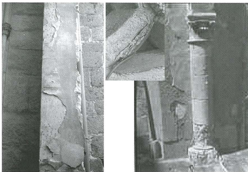
Figura 5. Aspecto de los revocos y enlucidos que cubren la fachada sur de la catedral de Toledo a la altura del primero y segundo triforio.
