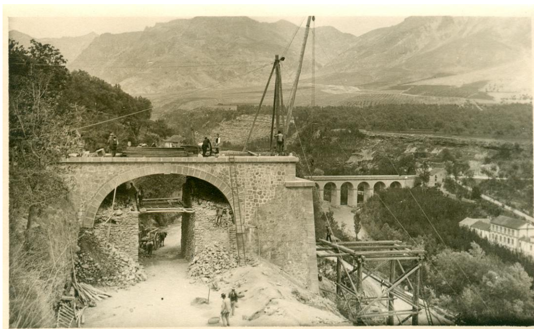
Fig. 4. Fotografía de la construcción del desvío inferior de la Carretera de Motril, coincidente con el estribo norte del nuevo viaducto. Fuente: Colección privada Jesús Ferro.
