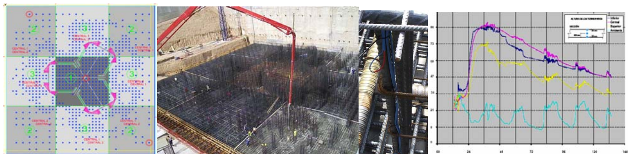
Figura 2. Distribución de pastillas de hormigonado, con previsión de suministro y días de hormigonado. Vista general del segundo día de hormigonado de la primera tongada. Termopares.
