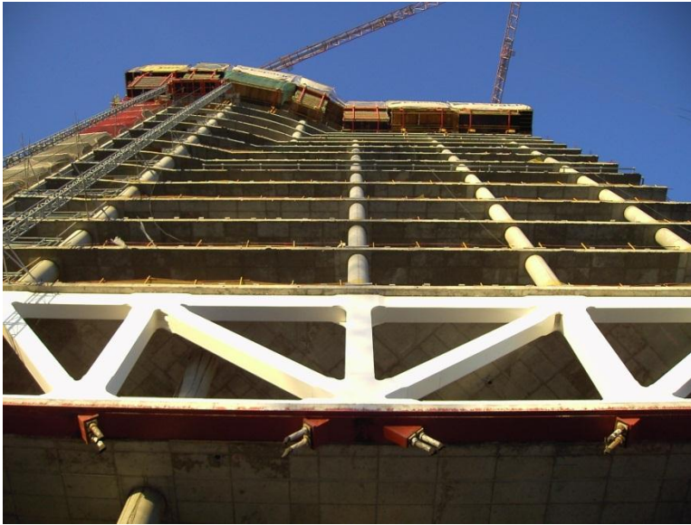
Figura 2 Viga cargadero 2 (fachada sur) de TORRE ESPACIO
