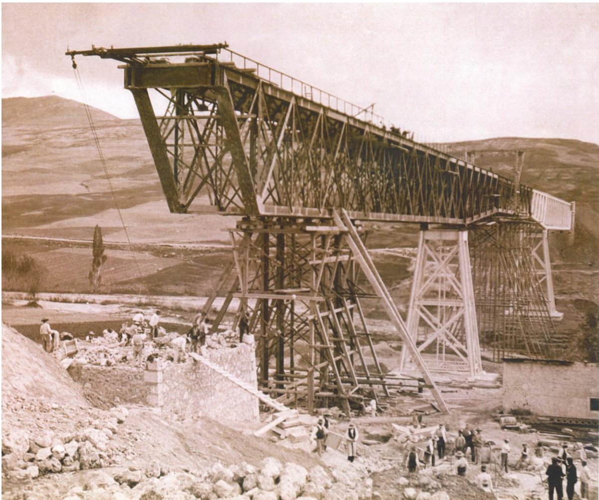
Fig. 1. Reconstrucción del estribo, según fotografía titulada “Bridge and new abutment”, tomada el 9 de mayo de 1906 por Gustavo Gillman. Fuente: Colección privada Herederos Gustavo Gillman .
