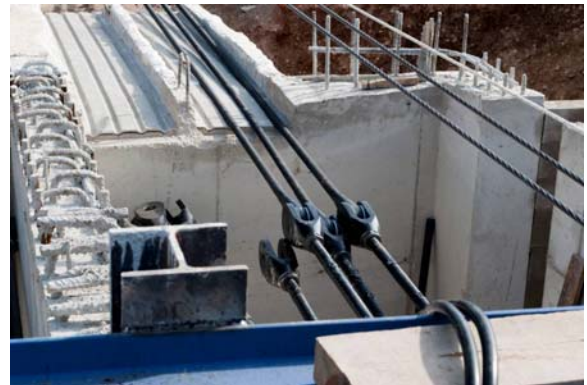
Figura 6. Detalle de junta entre cables y barras de anclaje
