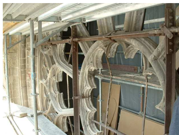
Detalle de la estructura metálica de soporte provisional
