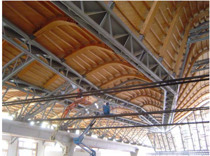
Fig. 5. Vista inferior de la cubierta con el zig-zag de la viga metálica.
