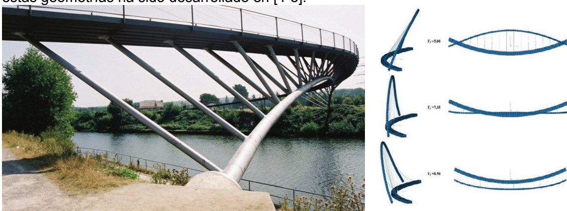
Fig. 8. Izquierda: Pasarela de Ripshorst (1997). Derecha: Efecto de la posición transversal arco-tablero sobre la directriz antifunicular del arco [4-5,7].
