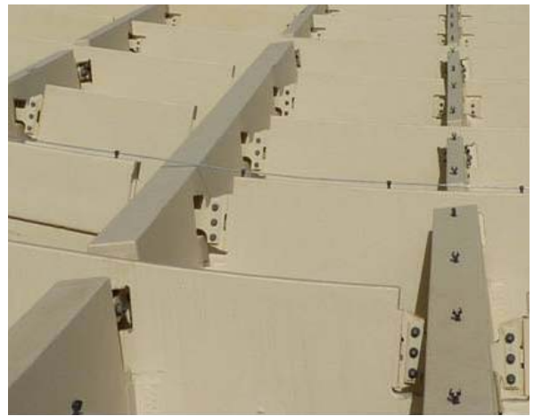
Figuras 3 y 4. La estructura de madera con espesores diferentes
