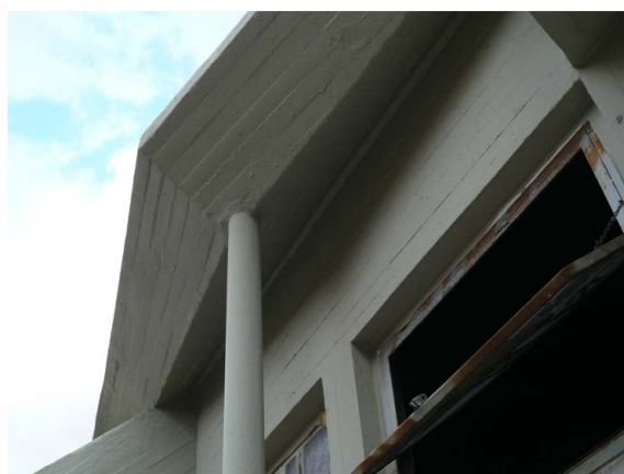
Figura 16. Fotografía actual de la colocación del bajante en relación con la cubierta
