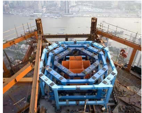
Figura 7. Sistema de amortiguación de masa sincronizada
