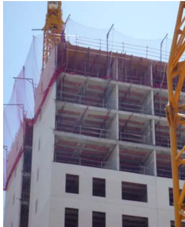
Figura 5 (izquierda) Núcleo estructural realizado con paneles que cumple la función de arriostramiento.
