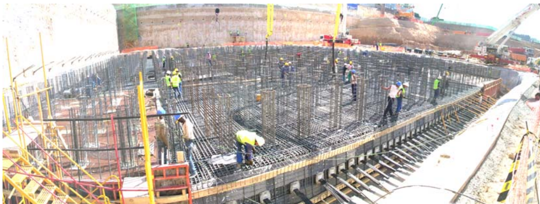
Fig 6.- Construcción de la losa de cimentación
