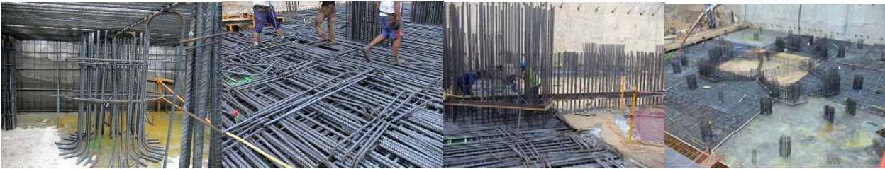
Figura 3.- Arranque de soportes de torre y cierre de torretas de cortante, plantilla de colocación de armado de núcleo y vista general del hormigonado de la segunda tongada de losa.
