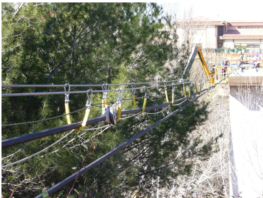
Figura 7: Lanzamiento de tirantes
