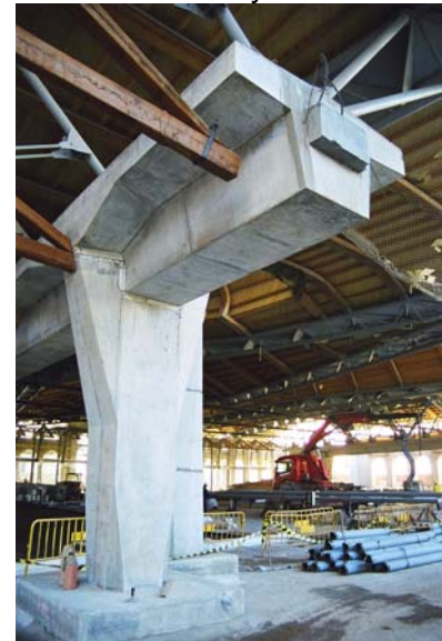
Fig.2.- Pilares de hormigón. Reducción de la sección inferior. Fig. 3.- Foto de pilar de hormigón.
