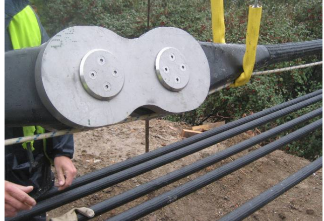
Figura 4. Detalle de junta entre tramos de cables
