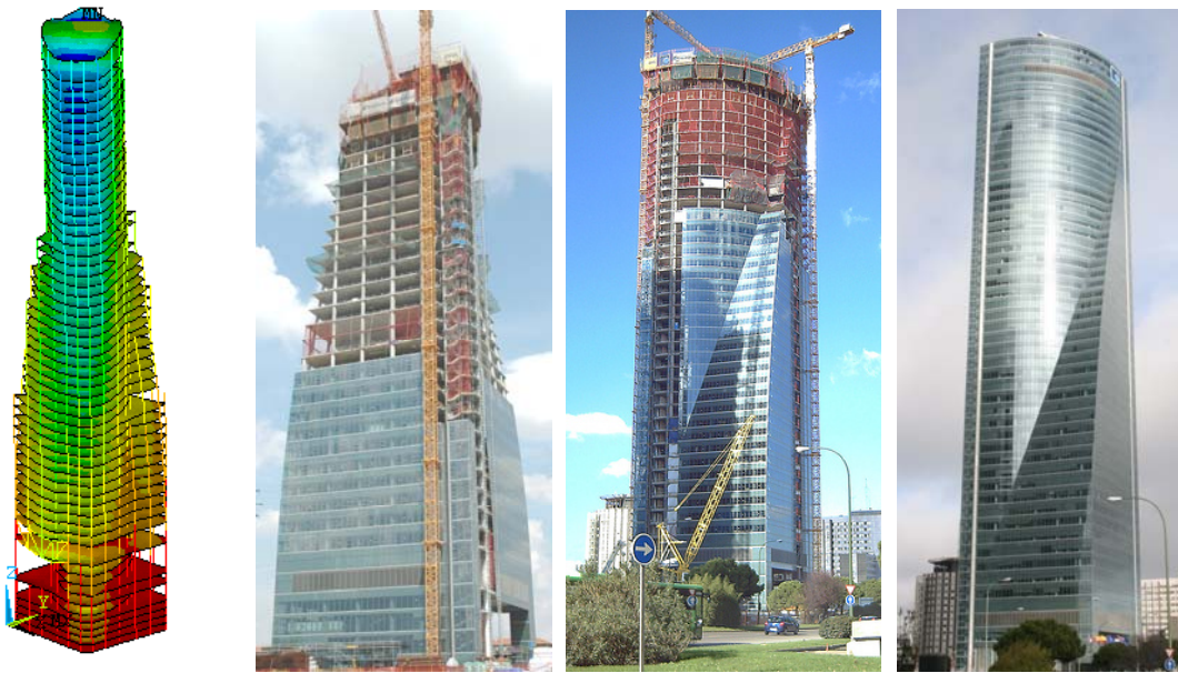
Fig 1.- Torre Espacio. Modelo de cálculo, diversas fases de ejecución y edificio terminado.
