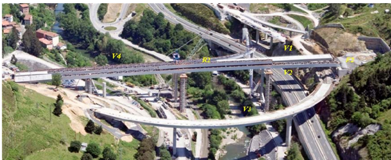
▲ Vista aérea después de lanzar V1 y V2 y de descender V4. Pórtico en P2 durante el desmontaje. R2 listo para ripar y deslizar.
