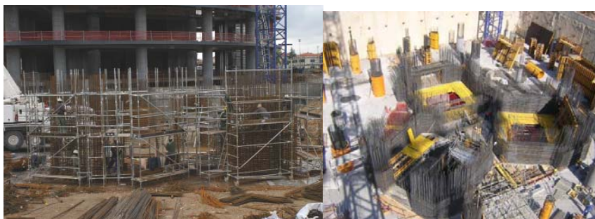
Figura 4.- Vista de taller de ferralla con despiece de armado de núcleos y armado en posición.
