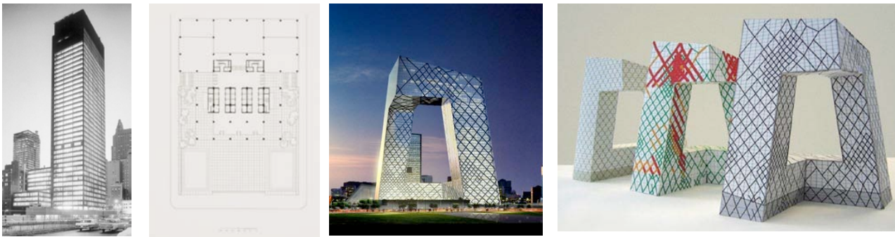
Figura 3 – Edificio Seagram: (1) vista exterior del edificio (2) plano de planta y (3) esquema núcleos. Sede CCTV: (3) vista exterior y (4) maquetas del proceso evolutivo de diseño estructural.
