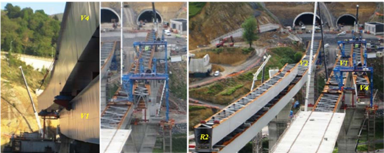
Giro y ripado de V4 sobre V. Vista general desde el E2. Descenso de V4 (210 m y 625 T) a su posición final.
