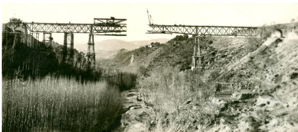
Fig. 10. Ejecución de las ménsulas. Fuente: Colección privada Jesús Ferro.
