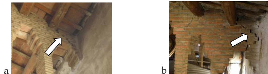
Graf: 5 Fisuras localizadas en el extremo superior del arco: (a) de la nave izquierda-A y (b) de la nave derecha-C.
