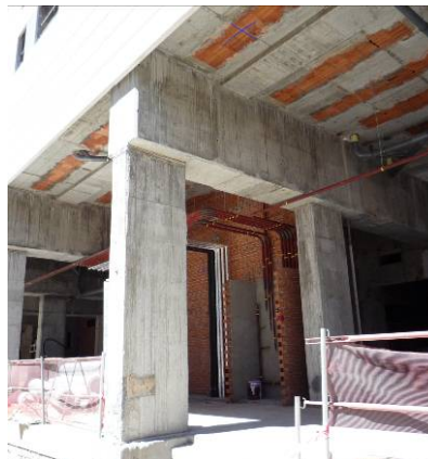
Figuras 3 y 4. Detalle de apoyo de los paneles portantes estructurales en planta baja, para la transmisión de cargas a las plantas sótano.
