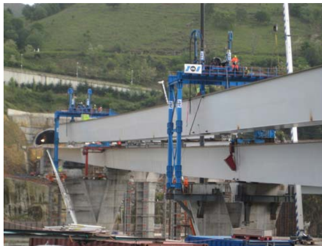
▲ Descenso de V4. Detalle de los pórticos de VSL en P1 y P2.
