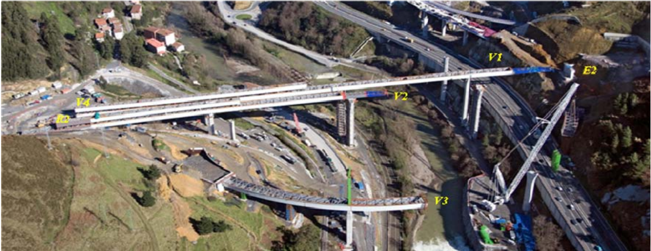
▲ Vista aérea durante lanzamientos. V1 cerca de E2 con V4 sobre él. V2 pasado P2 con R2 sobre él. Abajo, cables temporales en V3.
