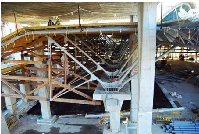
Fig. 6 Foto de las cerchas en construcción.
