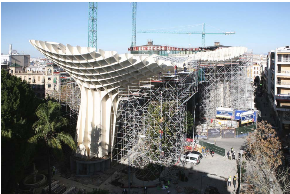
Figura 9: Vista de la estructura parcialmente cimbrada
