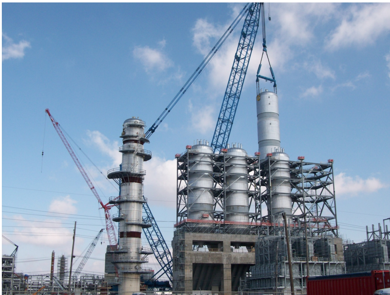
Figura 7. Proceso de izado de las cámaras de coque, estando ejecutada parte de la estructura principal.
