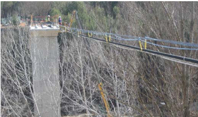
Figura 5. Lanzamiento de cables con tirolina auxiliar
