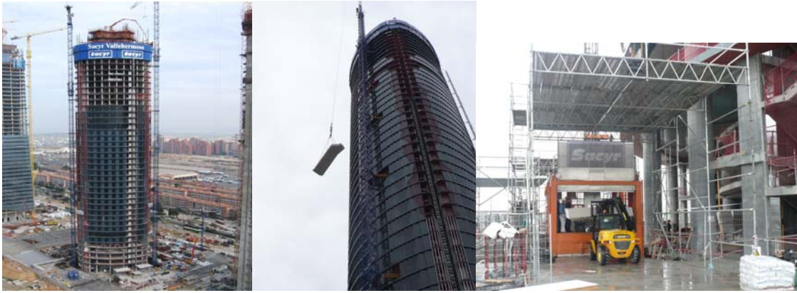
Figura 9. Ciclo tipo e instantánea de la obra en fase de máxima producción. Protección perimetral. Escaleras prefabricadas. Grúas y Montacargas.
