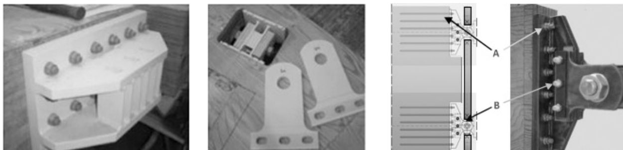
Figuras 5, 6 y 7. Piezas metálicas de la unión y barras encoladas
