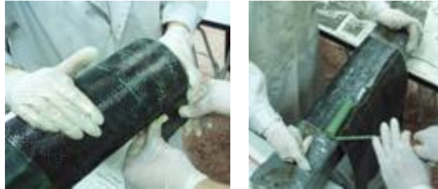
Figura nº2. Proceso de refuerzo
