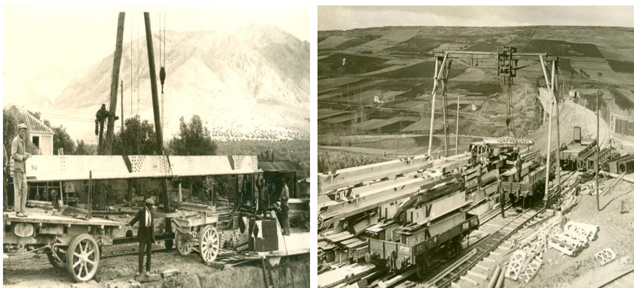
Figs 7 y 8. Transporte en vagonetas del material metálico del puente. Fuente: Colección privada Jesús Ferro.
