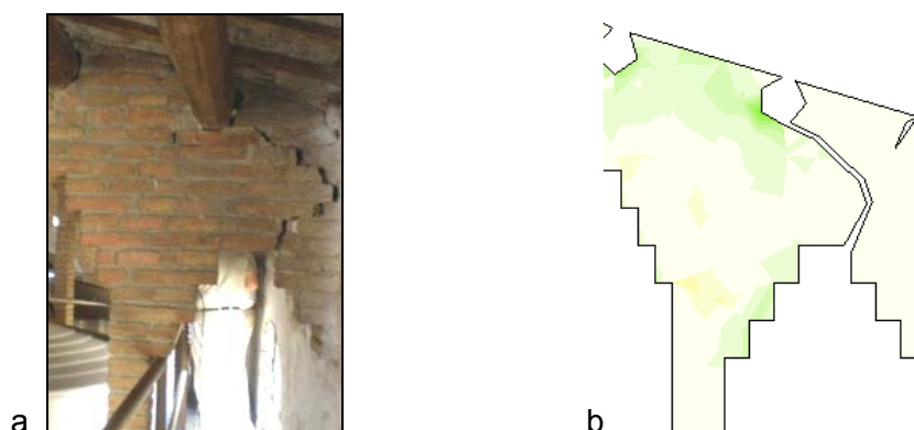
Graf: 11 Comparativa entre las fisuras reales (a) y el patrón de fisuración resultante (b).
