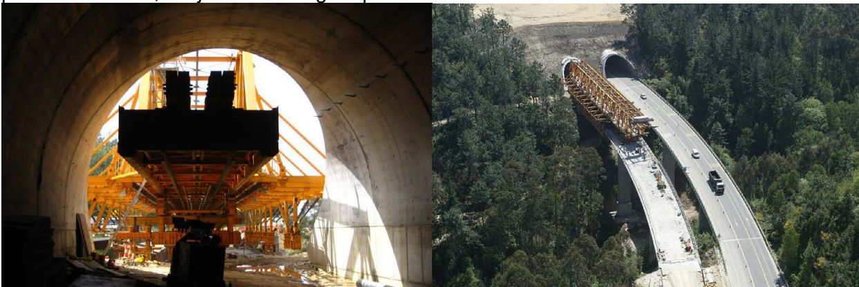
Fig. 7: "Entrada" de la nariz de la cimbra en el falso túnel de Ribón.
