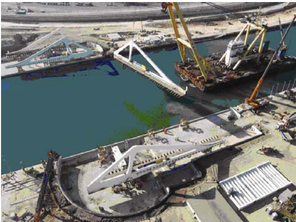
Fig. 9. Traslado de las hojas del puente rotatorio de Valencia
