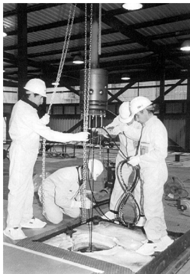
Fig. 18. Descenso de un dispositivo experimental en uno de los tres pozos del cajón del reactor de la central nuclear de Vandellós 1.
