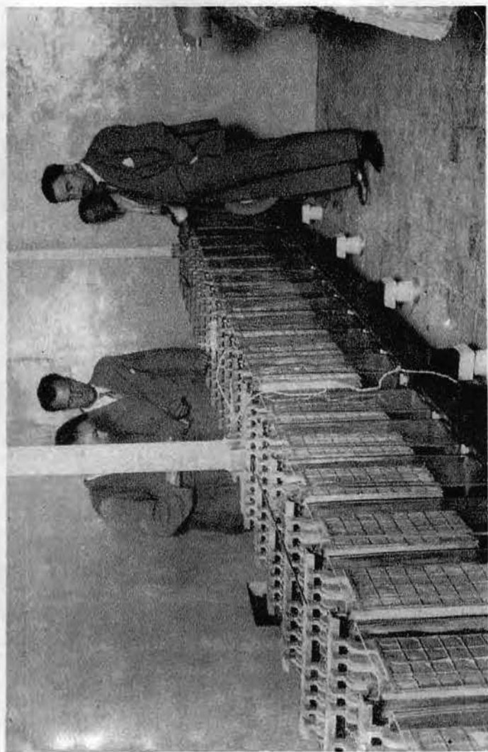
Inspeccionando los acumuladores del Instituto Nacional de Física y Química, que podían mantener durante una hora la luz de 180.000 bujías
