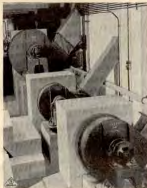
Fig. 13. Vista parcial de la serie de ventiladores para la ventilación de vitrinas.
