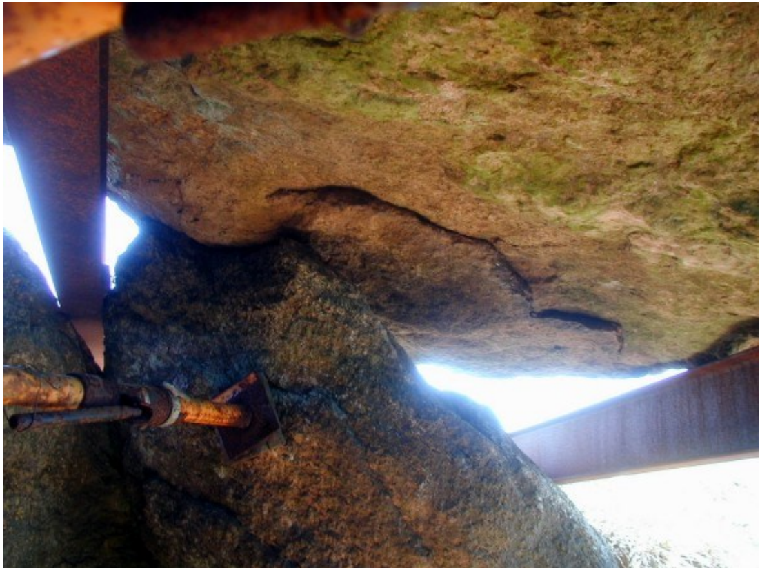
Figura 22. Fisura na cara interna da lousa de cuberta.
