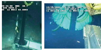
Figura 5. Salida de Fuel a través de la válvula de doble puerta instalada e ingreso del Fuel a la Bolsa Lanzadera, durante la Prueba Piloto de Extracción
