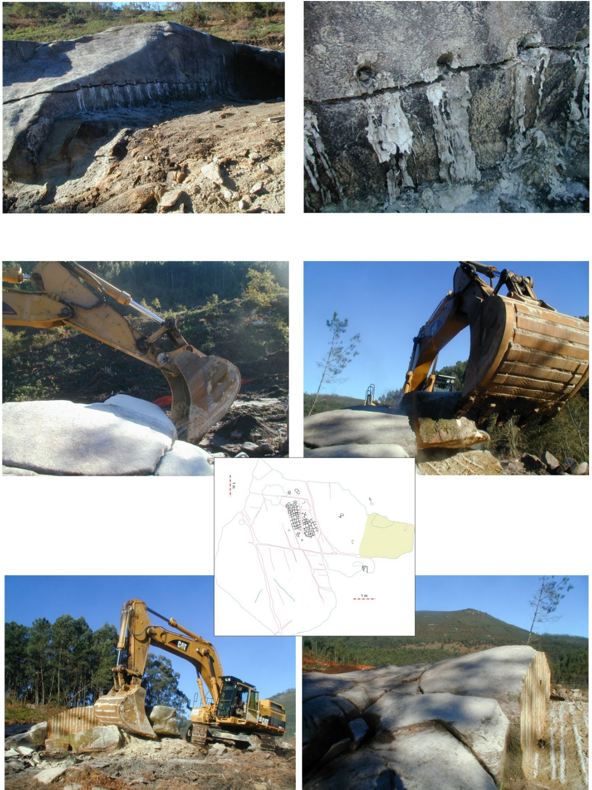
Figura 30. Nas dúas fotos de enriba amósase o estado da rocha tralos traballos de barrenado e de inserción de cemento expansivo. Abaixo: Traballos de extracción dun dos bloques da parte leste (en amarelo no calco), na última foto móstrase o estado da rocha despois da extracción.
