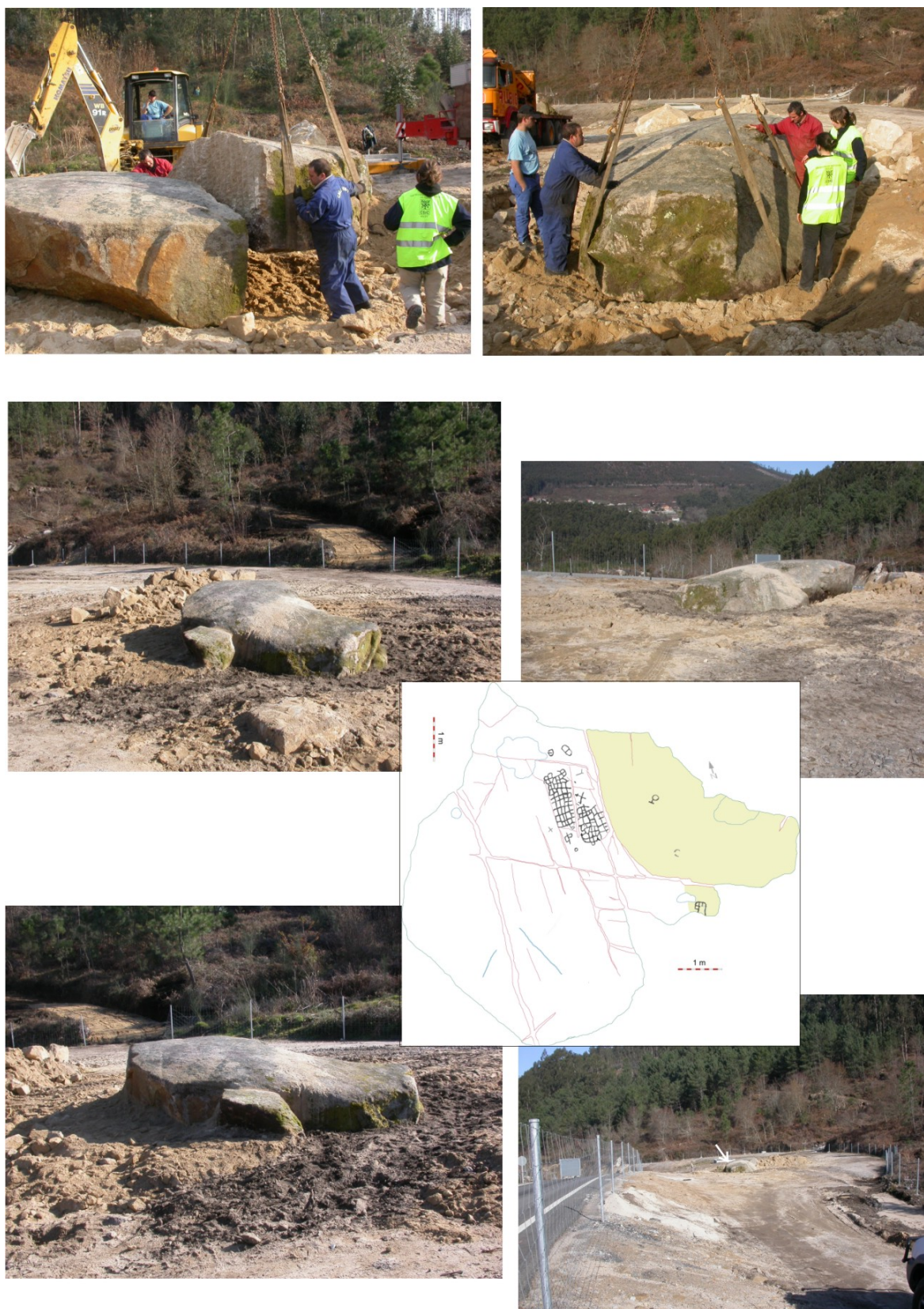
Figura 35. Traballos de colocación na rocha no novo lugar e estado final da mesma. No calco aparecen en amarelo as partes da rocha orixinal que puideron ser extraídas e reubicadas
