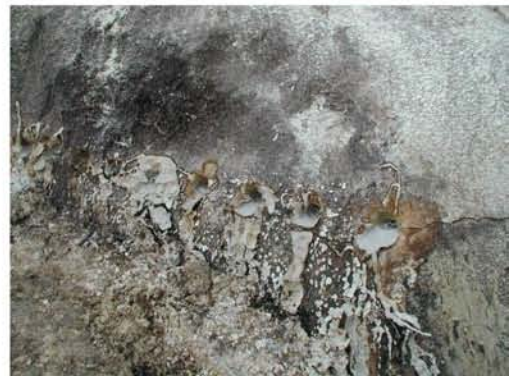
Cemento expansivo nas barrenas
