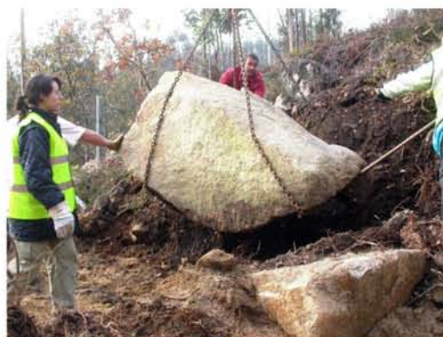
Colocación do primeiro bloque contra a pendente
