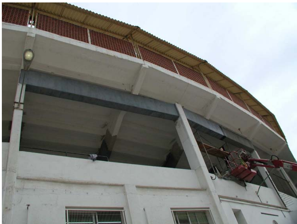
Foto 9: Vista exterior de la plaza de toros con las vigas reforzadas
