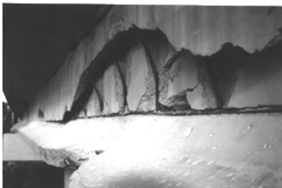
Fig. 6.1 Deterioros en viga de borde impactada, puente nº 5 del enlace del Escorial, Madrid
