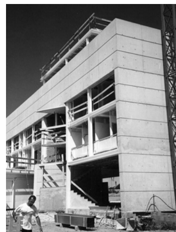
Fig. 6.7 Vigas de gran canto en zona superior del edificio
