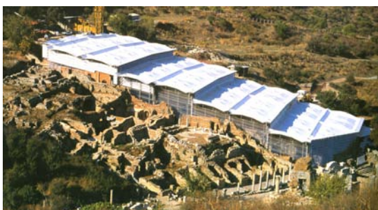
Fig. 11: Cubierta de la Casas de la Ladera, Efeso. Estructura ligera modular para excavaciones arqueológicas
