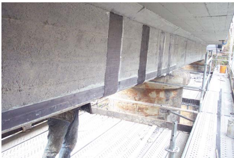
Fig. 6. Laminado de fibras de carbono en Puente en Zumárraga
