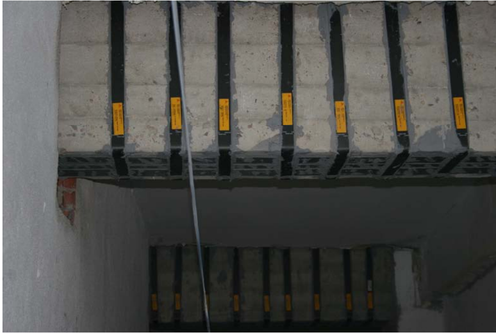
Foto 8: Vista del refuerzo a cortante de una de las vigas
