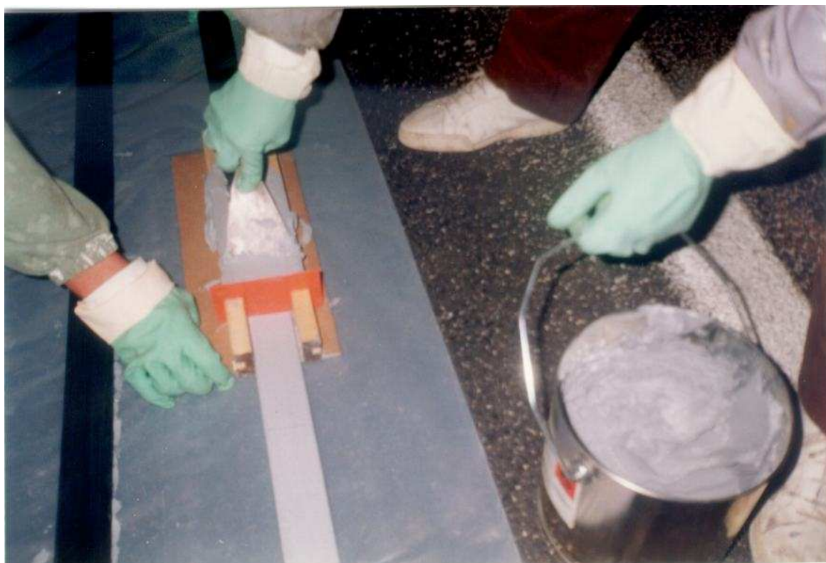
Foto 4: Aplicación de la resina sobre el laminado
