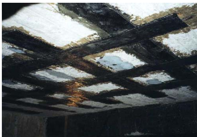
Fig. 9. Refuerzo con TFC®
