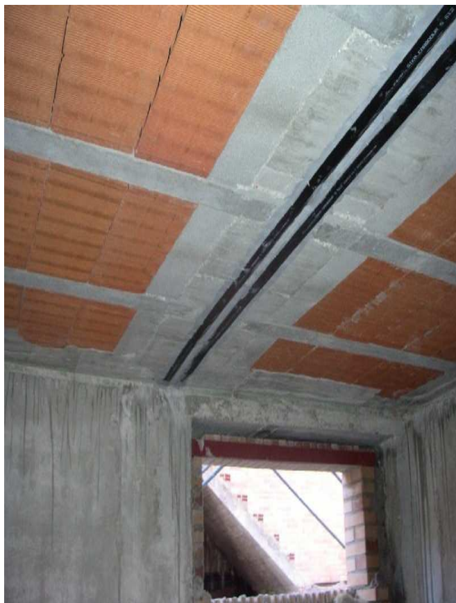
Foto 2: Detalle del refuerzo de vigas
