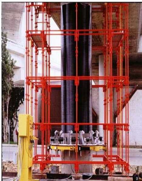
Fig. 2.2 Bobinado automático de fibra de carbono
