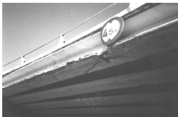
Fig. 6.2 Deterioros en viga de borde impactada, puente nº 6 del enlace del Escorial, Madrid
