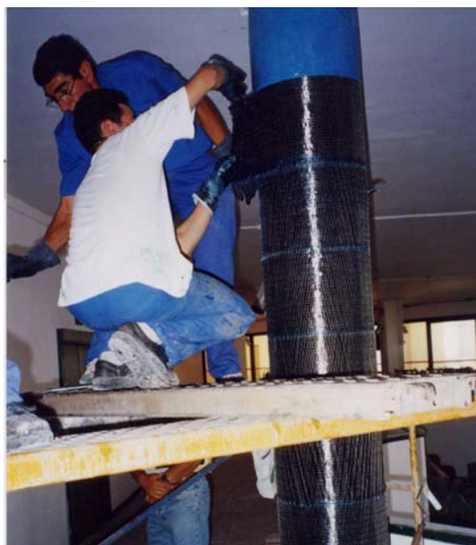
Fig. 2.1 Aplicación de fibra de carbono mediante wrapping
