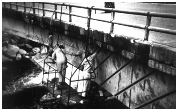
Fig. 4.6b Aplicación de MC tipo roving como refuerzo a cortante en puentes. Colombia
