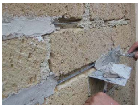
Fig. 4.2 Barra de GFRP pultruida incorporada en los tendeles de una fábrica
