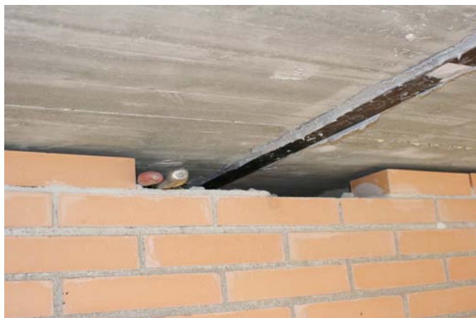
Foto 6: Vista de el refuerzo de una viga que atraviesa una partición
