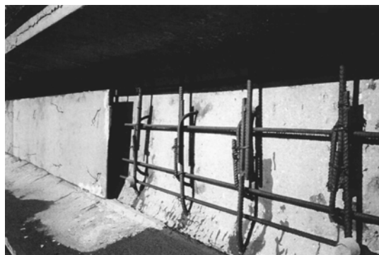
Fig. 6.3 Recrecido de almas (encofrado y armadura). Puente nº 6, Enlace del Escorial
