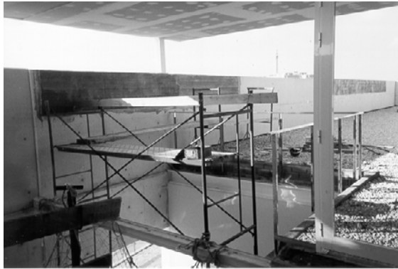
Fig. 6.8 Medios auxiliares ligeros empleados en la ejecución del refuerzo
