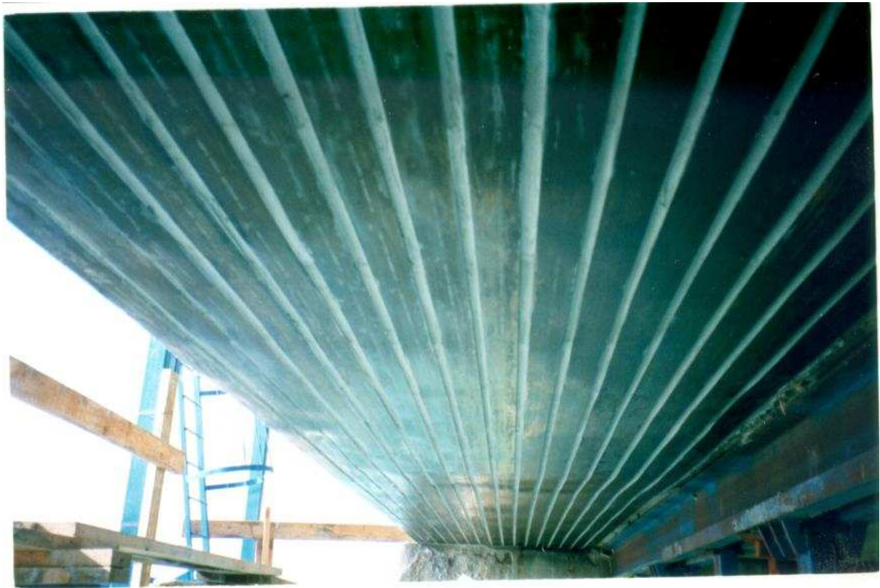
Foto 5: Vista inferior de la viga del puente después de reforzarse
