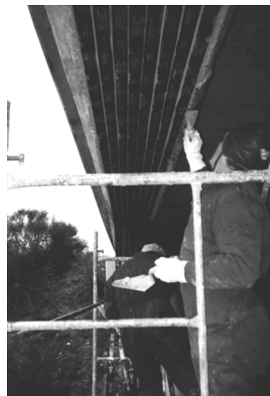
Fig. 6.4 Colocación de los laminados. Puente nº 5 del Enlace del Escorial
