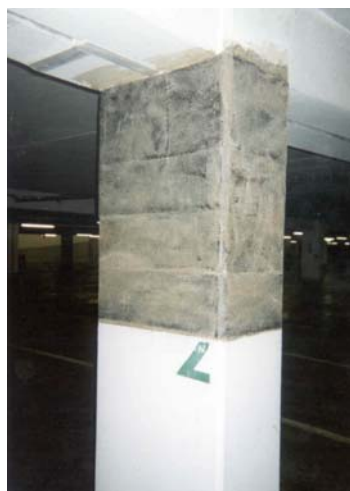
Fig. 14. Refuerzo de la cabeza de la viga
