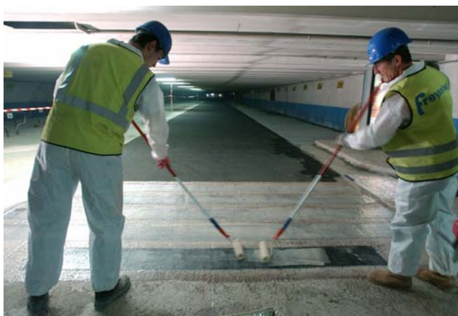
Fig. 11. Aplicación de segunda capa de resina
