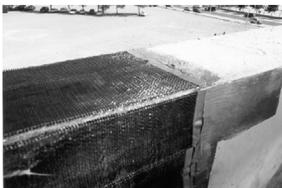
Fig. 4.6a Laminados rígidos constituidos como MC
