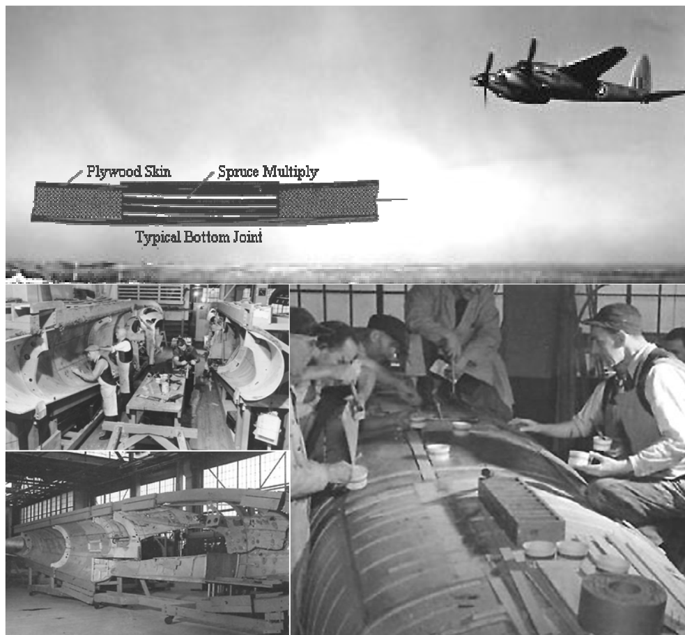
Figura 5: Detalle, vista general, fabricación de fuselaje y aplicación de adhesivo en el fuselaje de Mosquito
