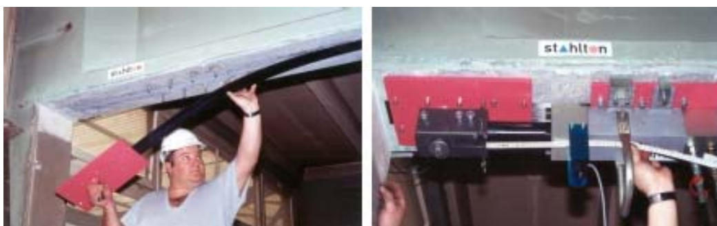
Fig. 3.1 Operativa para la aplicación de laminados postesados
