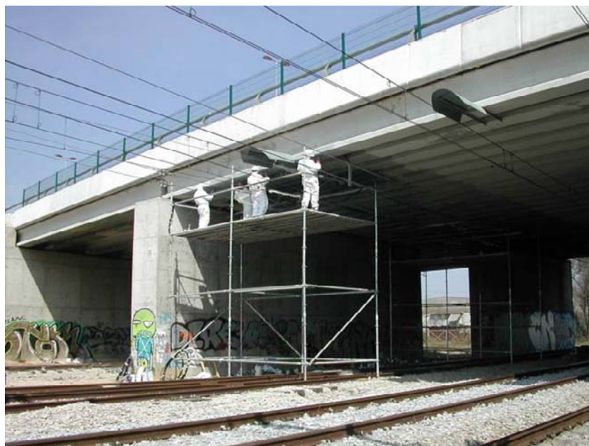
Fig. 8. Colocación del LFC
