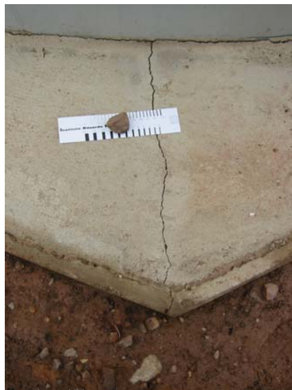
Figura 3.1. Fisura por secado en la parte expuesta de una zapata de aerogenerador.
