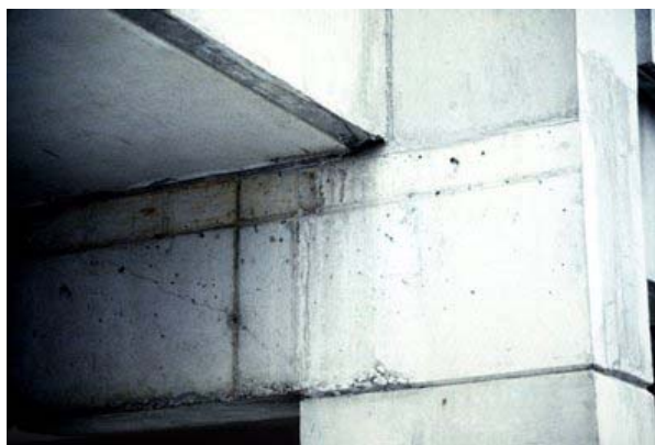
Figura 2.1. Fisuración por tensiones de cortante en una conexión viga-columna.
