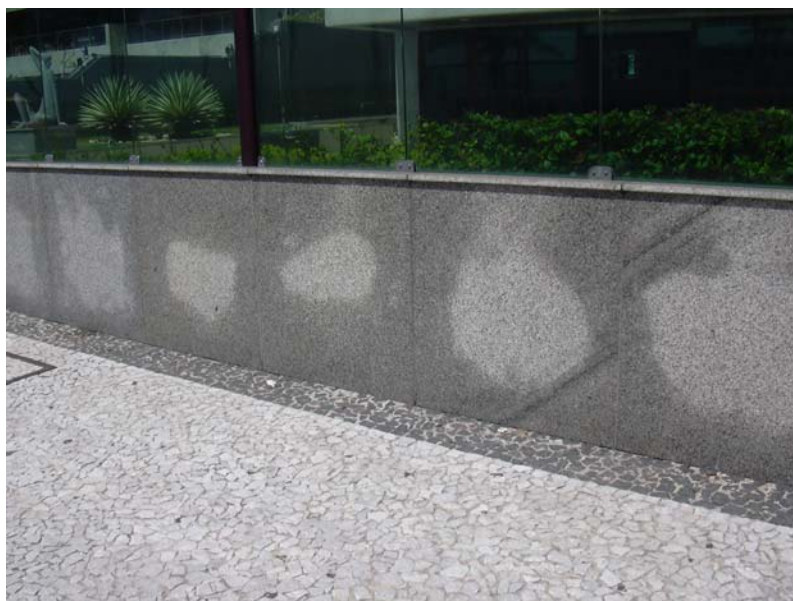
Foto.- 6. Manchas de humedad en un aplacado con un Granito gris.
