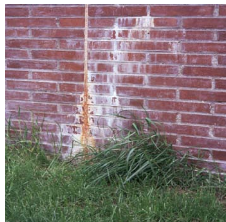
Figura 11.- Eflorescencias producidas por capilaridad del agua del jardín.
