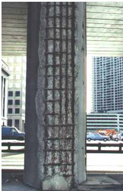
Figura 2.10. Desprendimiento por corrosión de la armadura.
