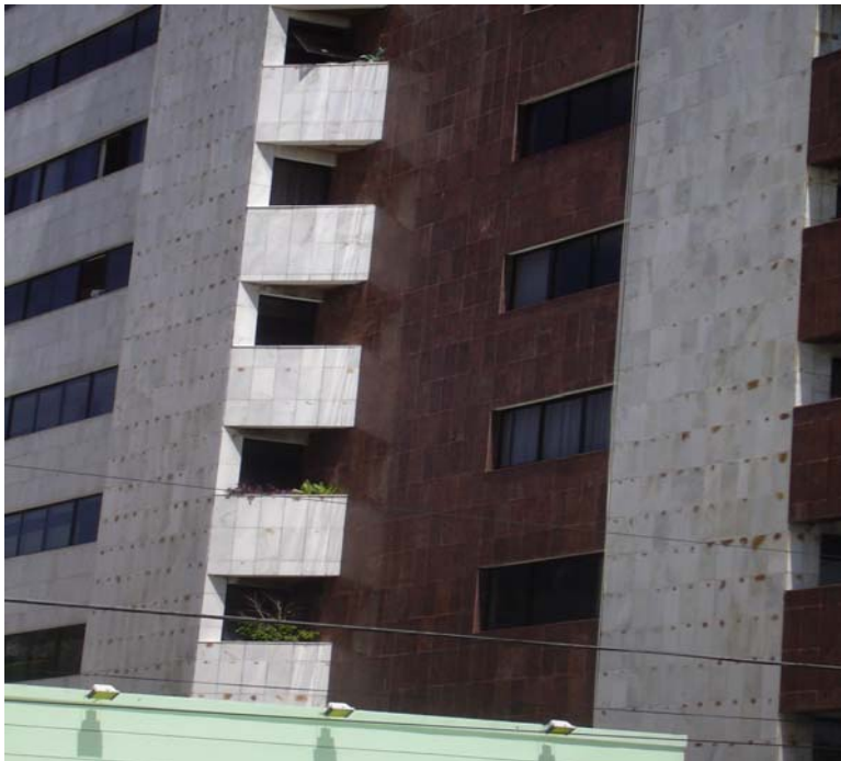
Foto.-3. Manchas de óxido en placas de mármol blanco sujetas con ganchos metálicos y mortero.
