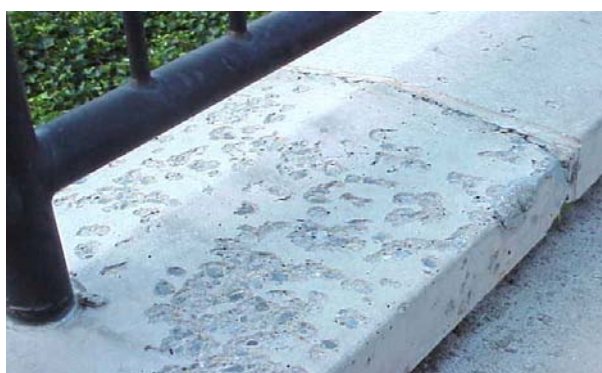
Figura 2.9. Llagas por hielo-deshielo
