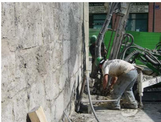
a) Inyección del micropilote
