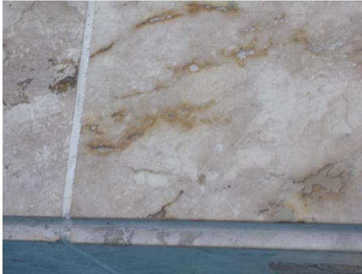
Foto.-4. Manchas de oxidación asociadas a un anclaje de acero galvanizado que han progresado a través de las anisotropías de una piedra caliza de color crema.
