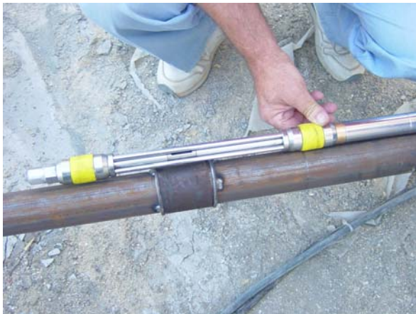
a) Sistema de micropilote con tubo-manguito
