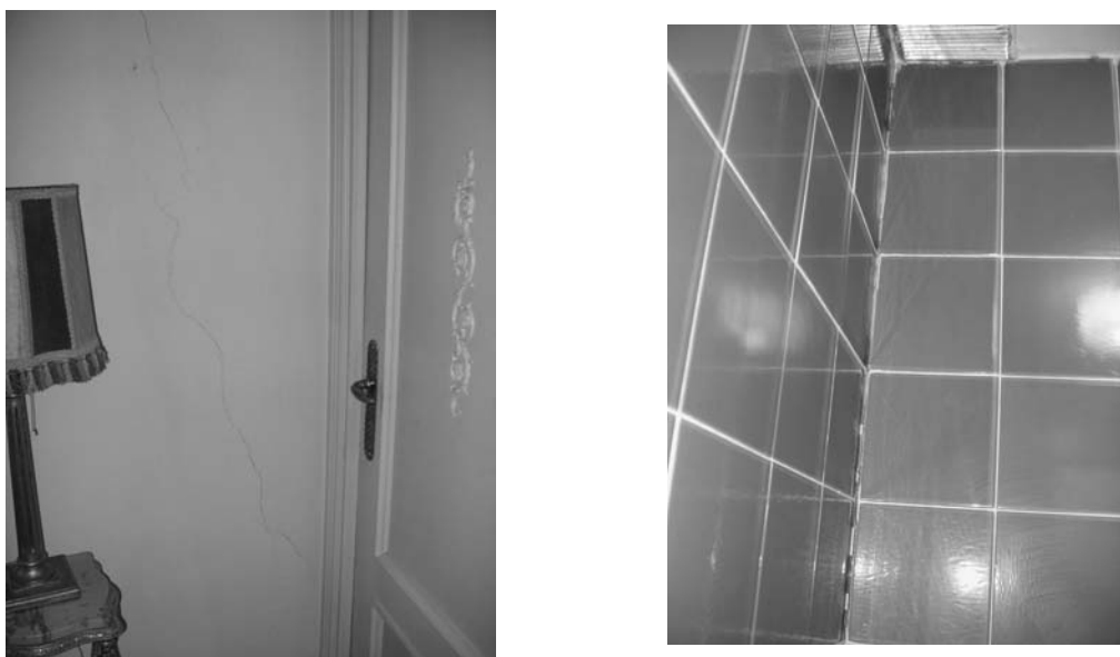
Figura 1 – Fisuración en tabiquería por excesiva flexibilidad de la estructura horizontal
