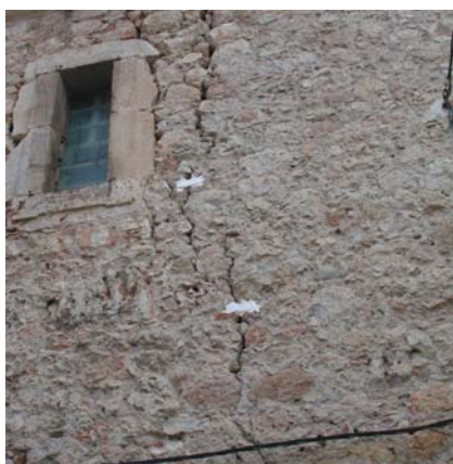
a) Testigos para control de movimientos
