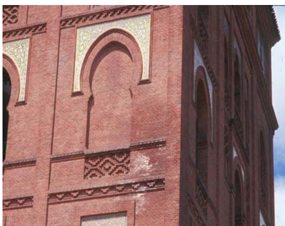
Figura 10.- Eflorescencias producidas por rotura de una conducción.
