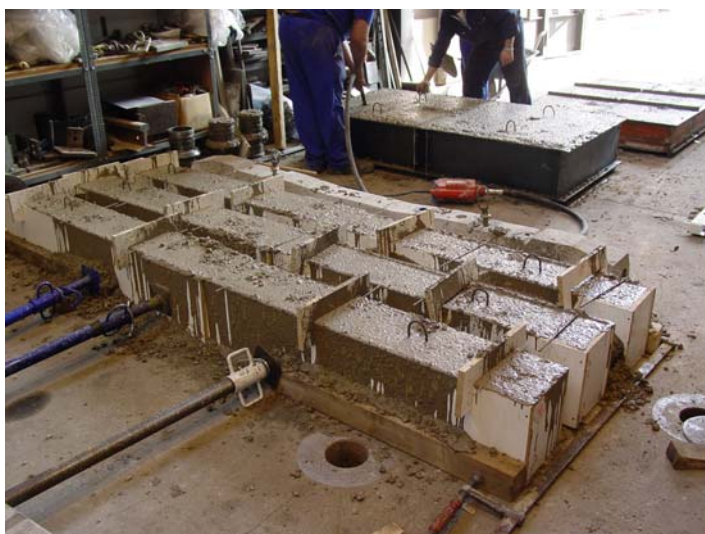
Figura 1. Hormigonado de vigas
