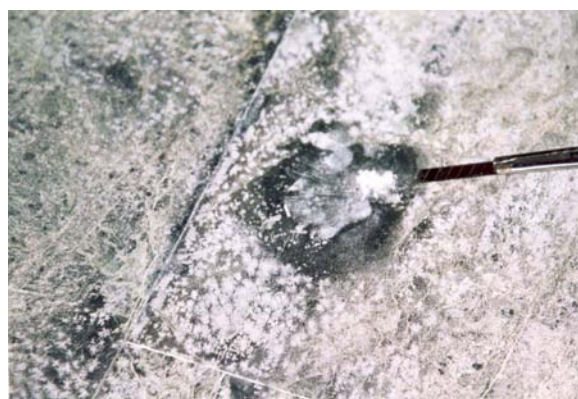
Figura 2.5. Zona de alteración con eflorescencias.
