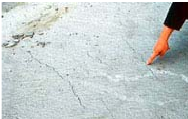
Figura 2.7. Fisuras por retracción plástica.
