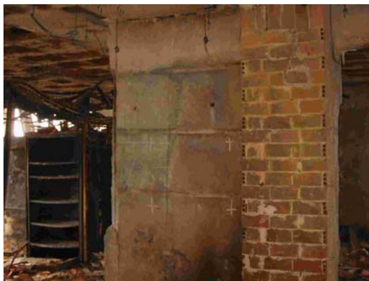
Figura 3.3. Cambios de tonalidad por distintas temperaturas de exposición.
