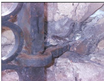
Figura 3.- Alteraciones producidas por la oxidación de elementos metálicos.
