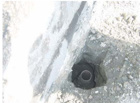
b) Cabeza del micropilote
