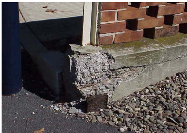
Figura 2.8. Desprendimiento por hielo-deshielo.
