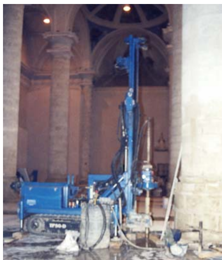
b) Máquina de sondeo sobre oruga
