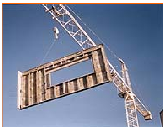
Figura 5: panel izado con grúa de obra
