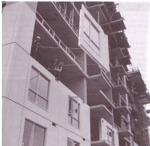
(Fig.5: Montaje de paneles prefabricados para edificio residencial de 26 plantas en San Diego, California (EEUU)) (Fuente: Lakeview/Centura Building System)
