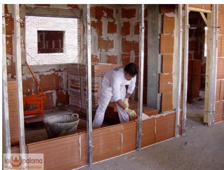
Sistema de partición con piezas de arcilla cocida de gran formato DIT 334-p Tabiceram. Cerámica La Paloma S.L.
