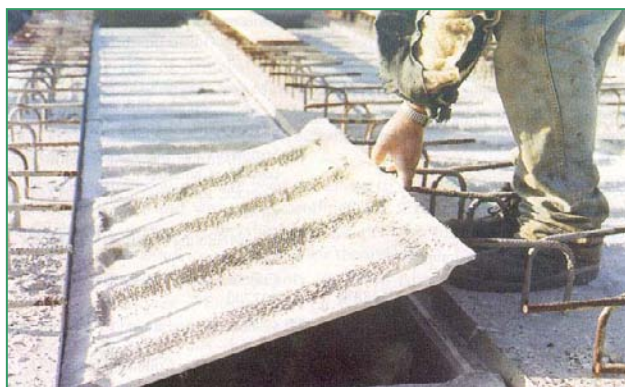
Figura 9: Encofrado perdido de GRC para forjado
