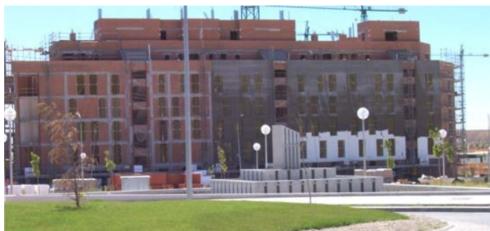
Fig.3.: ETICS sobre soporte de albañilería. Edificio Sunrise para 139 viviendas sociales en el Ensanche de Vallecas. Madrid (Fuente: ELR)
