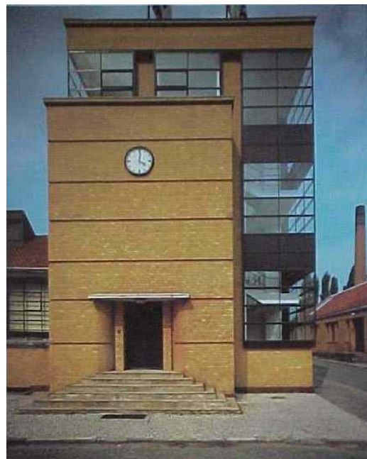
Fig.1-5. Factoría Fagus, con una envolvente de vidrio y acero de gran ligereza visual. Acero y vidrio han estado ligados desde un principio al lenguaje maquinista de la arquitectura del siglo XX.
