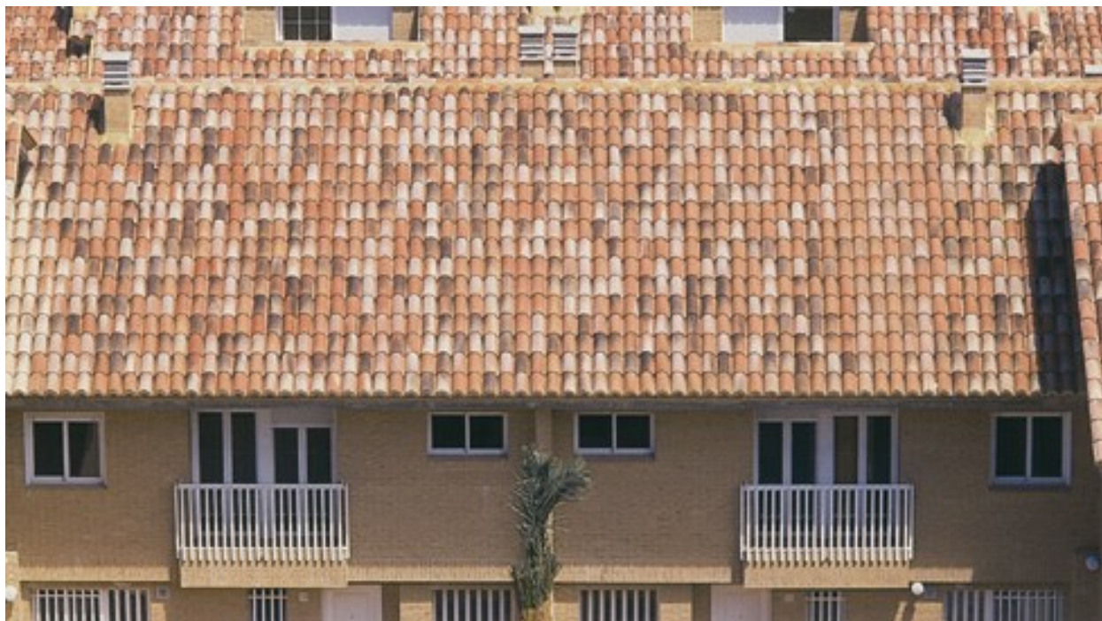
Fig. 2 Fotografía de Tejado con tejas curvas
