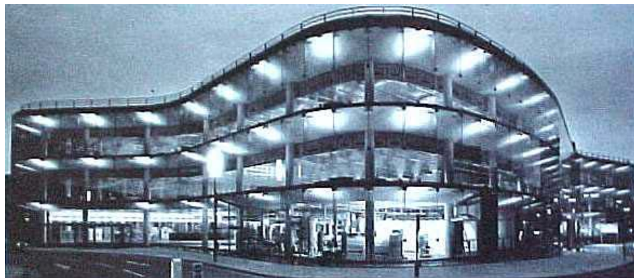
Fig. 1-10. Visión nocturna del edificio Willis Faber &Dumas, en la que se aprecia la inexistencia de carpintería soporte del vidrio.
