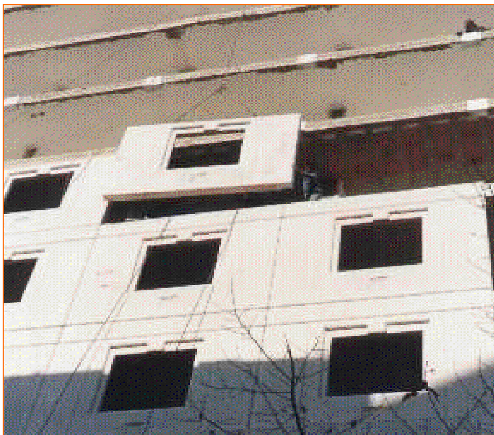
Figura 6: Colocación del panel en la fachada
