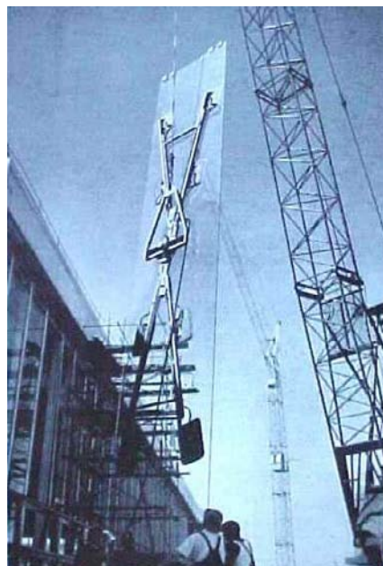
Fig.1-15. Aspecto del montaje de un volumen acristalado según el sistema Hahn.
