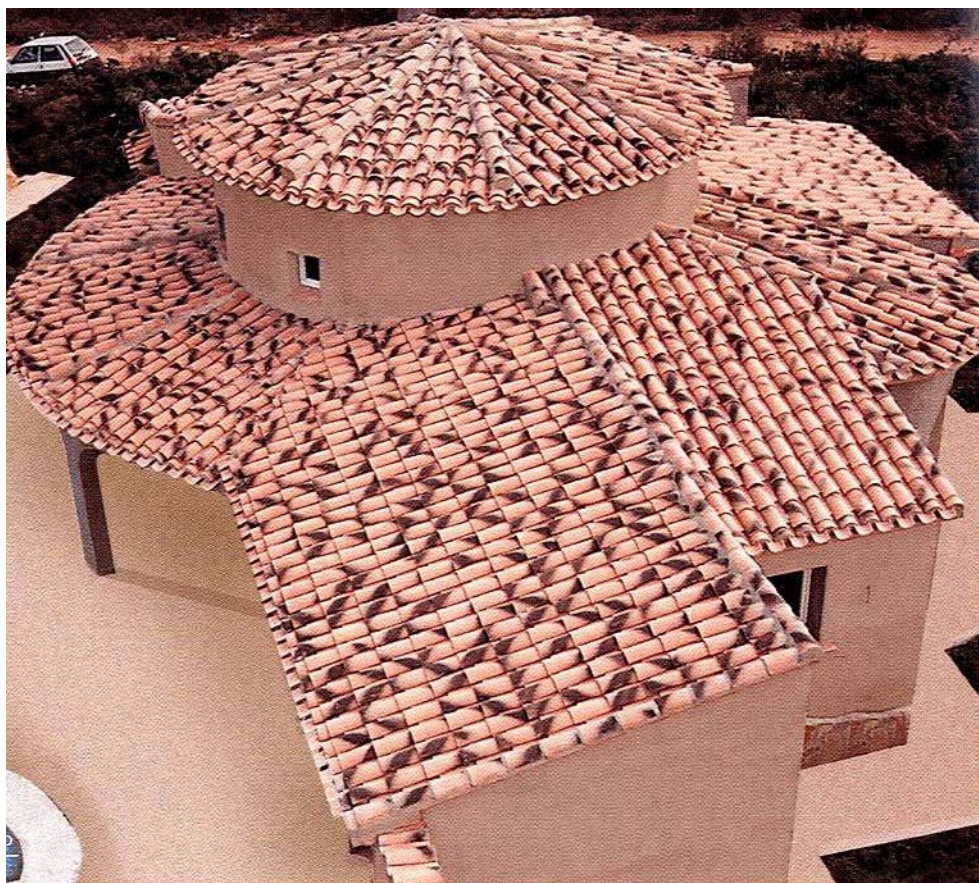
Fig. 7 Fotografía de Tejado con tejas curvas engobadas
