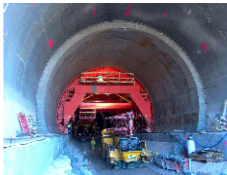
Figura 3. Izq.: Muro pixelado construido con HAC en el Museo Óscar Domínguez de Tenerife, 2005. Dcha.: Refuerzo, mediante HAC, del revestimiento de los túneles del Montblanc en la L.A.V. Madrid-Zaragoza-Barcelona, 2005.
