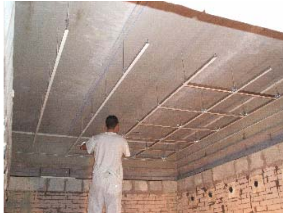
Fig. 3.2 Montaje de muestra de ensayo
