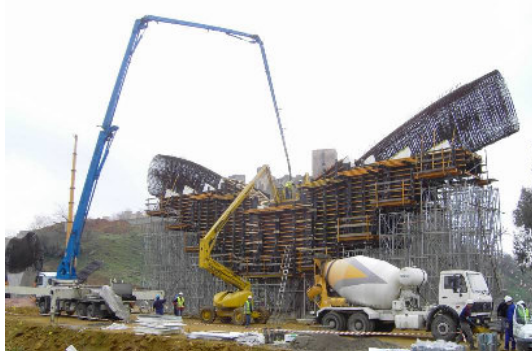
Figura 8 . Bombeo del hormigón autocompactante
