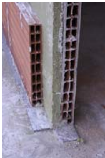
Figura 4.3. Elementos de fábrica sobre bandas elásticas.
