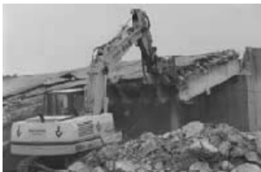
Fig. 1 – Demolición de estructuras cuyo tratamiento del residuo produce el árido reciclado procedente de hormigón
