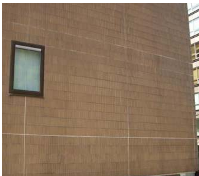
Fig. 12 – Juntas de dilatación en alicatado
