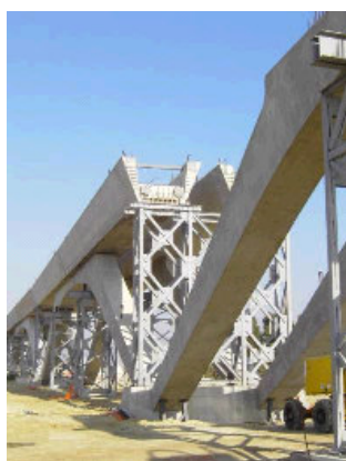
Figura 4. Izq.: Empleo de HAC en la fabricación de 188 vigas artesa para la L.A.V. Sevilla-Cádiz en la Variante de El Portal. Dcha: Construcción de 248 viviendas en Jerez empleando HAC en cerramientos exteriores, divisiones interiores, forjados y escaleras, 2006.
