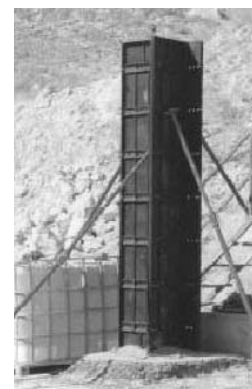
Fig. 8 – Encofrados de las estructuras hormigonadas en la prueba industrial
