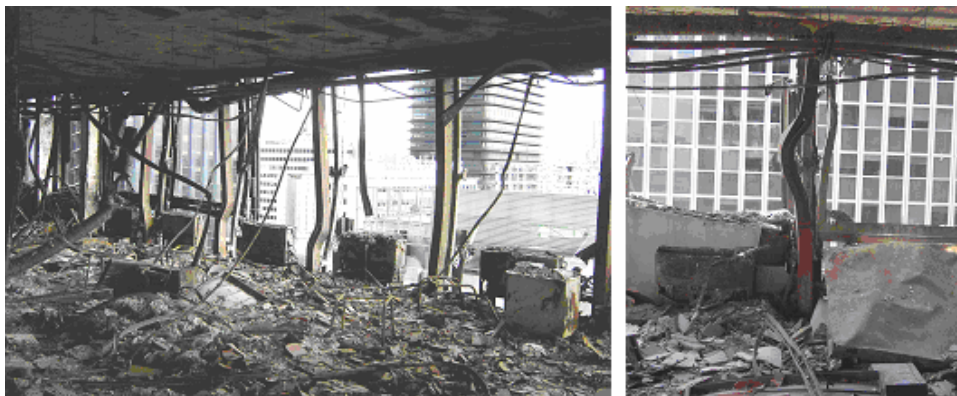
Fig. 7 Pilares metálicos de fachada pandeados en planta 9ª
