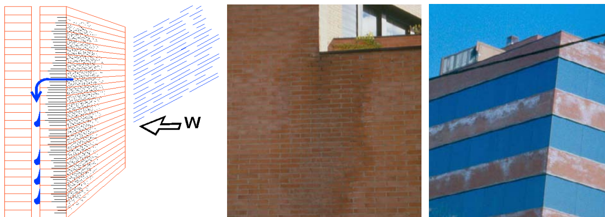
Fig. 6 – Filtración en paño de ladrillo visto, con posibles eflorescencias
