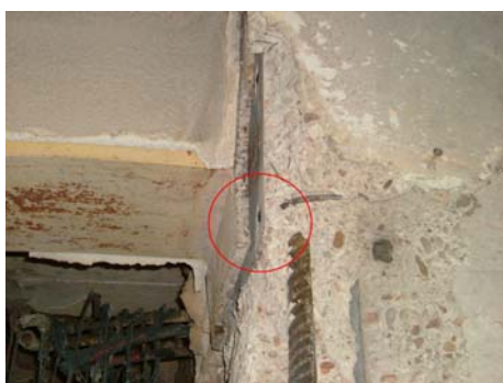
Fig. 9 Arrancamiento de placas de anclaje de vigas mixtas.
