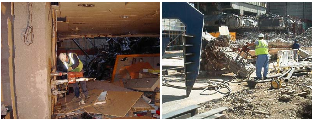
Fig. 13 Extracción de probetas-testigo en el interior del edificio y en elementos ya desmontados
