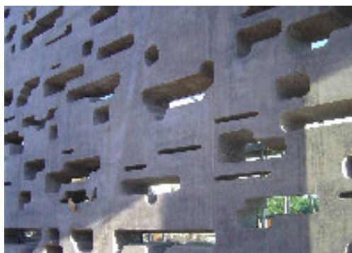
Figura 3. Izq.: Muro pixelado construido con HAC en el Museo Óscar Domínguez de Tenerife, 2005. Dcha.: Refuerzo, mediante HAC, del revestimiento de los túneles del Montblanc en la L.A.V. Madrid-Zaragoza-Barcelona, 2005.
