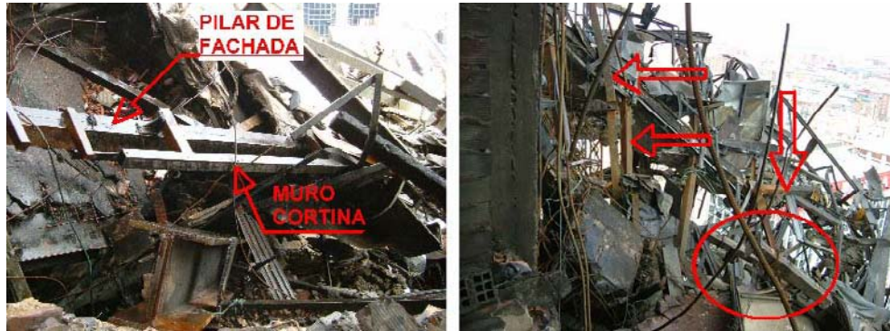
Fig. 6 Pilares de fachada no ignifugados y montantes de la estructura del nuevo muro cortina
