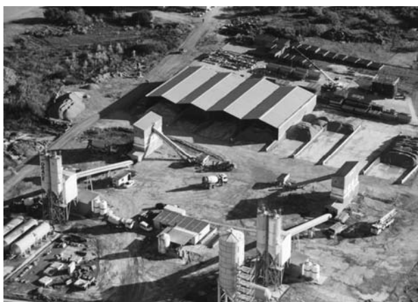
Figura 6. Vista de las dos plantas de hormigonado y de los silos de cemento
