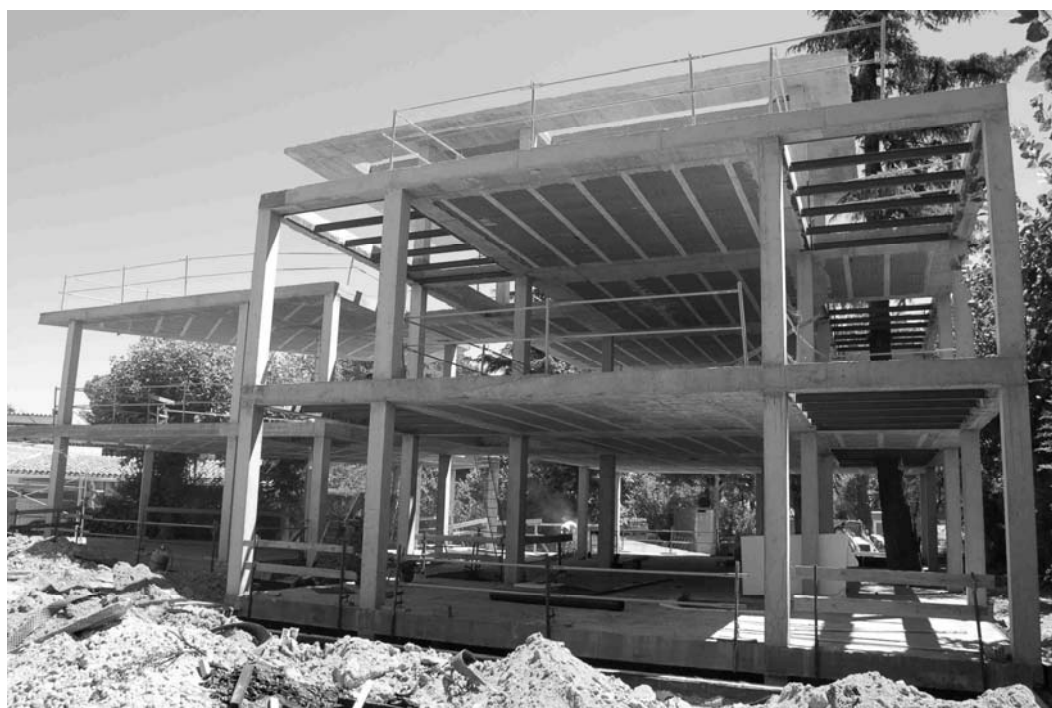
Fig. 13 – Imágenes durante la aplicación del hormigón con árido reciclado
