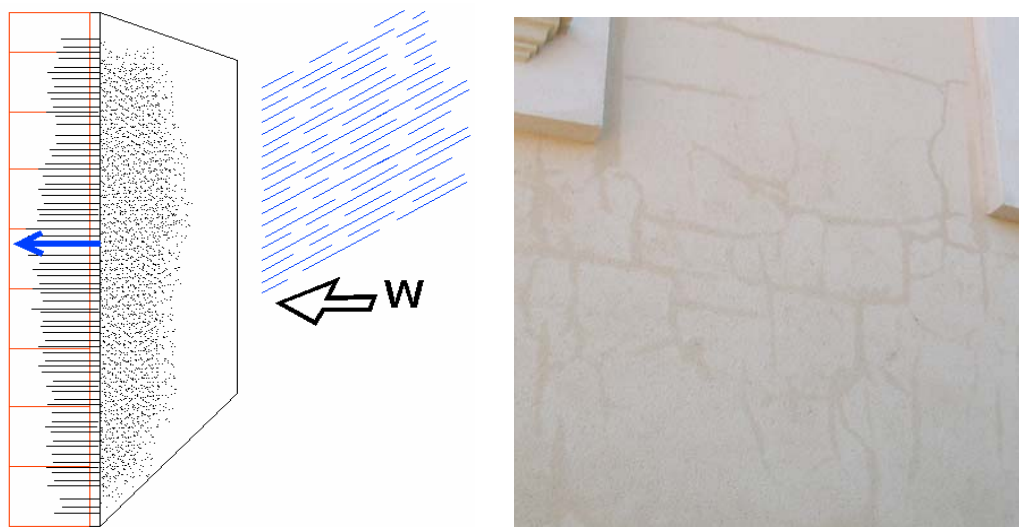
Fig. 10 – Filtración en paño con revestimiento continuo y expresión de fisuras en revoco
