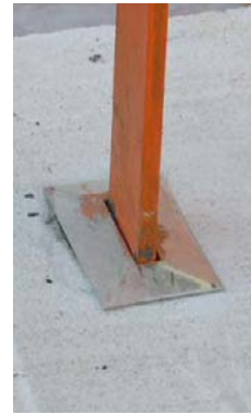
Fig. 22 – Sujeción de barandillas
