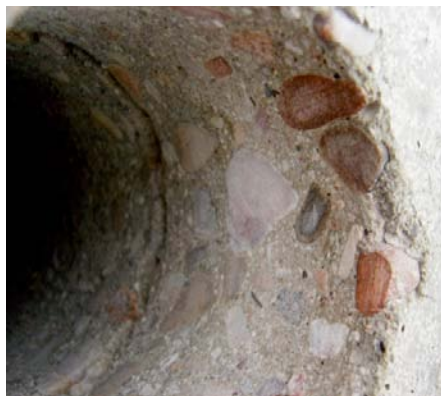
Fig. 7. Aspecto de coloración del hormigón del edificio Windsor (18), 2006)
