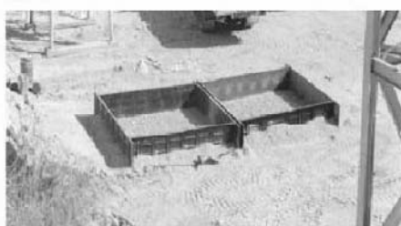
Fig. 8 – Encofrados de las estructuras hormigonadas en la prueba industrial
