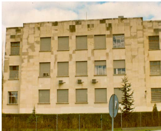
Fig. 5 – Mayor nivel de exposición en coronación y esquinas
