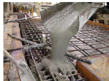
Figura 1. Fluidez, capacidad de paso entre armaduras y resistencia a la segregación son las características esenciales del hormigón autocompactante.
