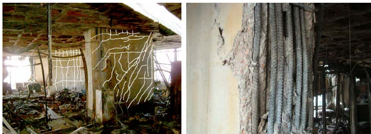
Fig. 8 daños en pilares de hormigón
