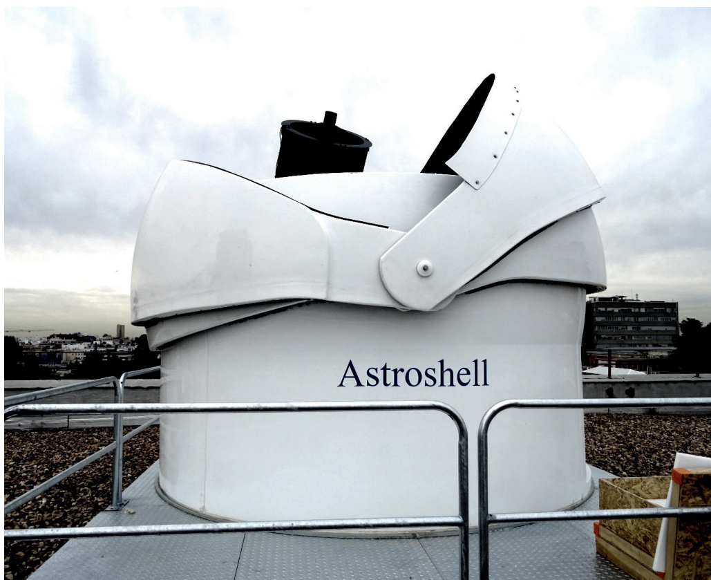
Fotografía de la estación óptica terrenal (Optical Ground Station, OGS) para criptografía cuántica con satélites, en proceso de instalación y montaje en el ITEFI.
