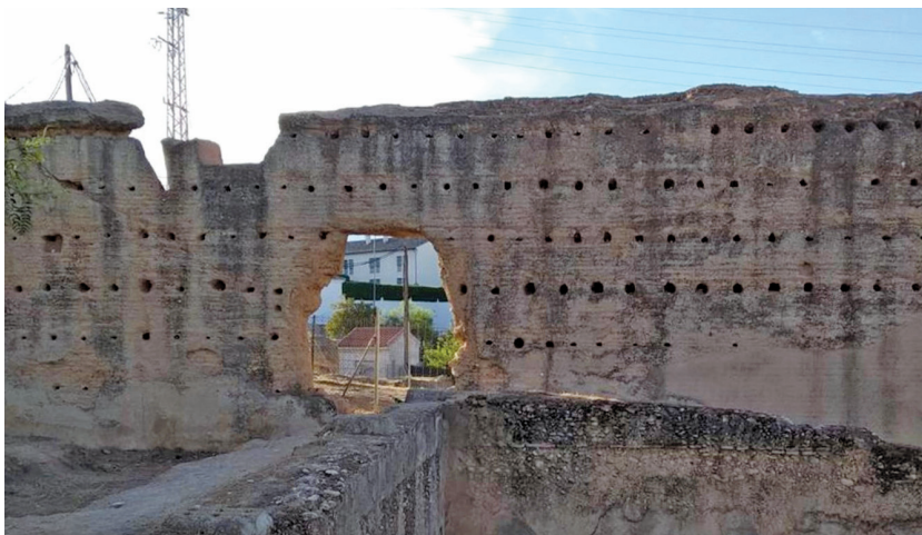
Puerta abierta en la muralla, frente a la ubicación de la antigua rábita. Imagen procedente de Internet.
