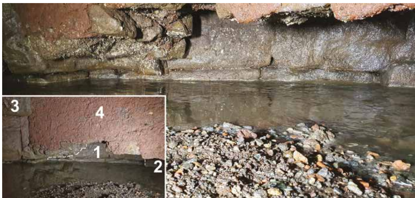
Figura 6. Il tratto del canale di età arcaica in blocchi di cappellaccio (1) inglobato nelle sponde della Cloaca Massima di età repubblicana (2-3), parzialmente rivestito con da uno spesso strato di cocciopesto (4). Il punto indicato nell'immagine con il n.º 3 corrisponde alla muratura del nuovo ramo della Cloaca Massima che sottopassa via S. Giovanni Decollato prima di sboccare al Tevere nella posizione attuale.
