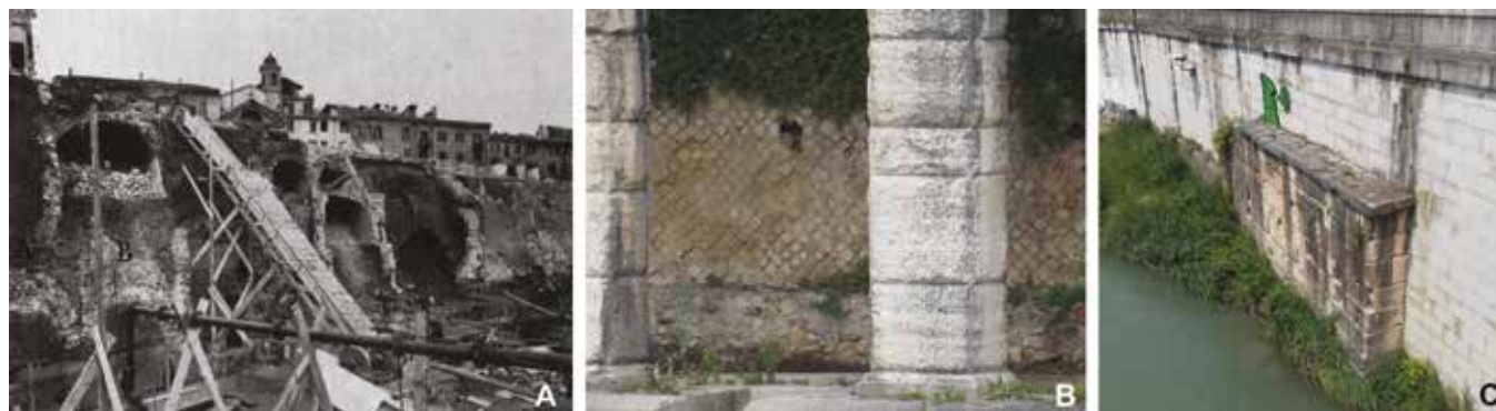
Figura 7. Gli argini fluviali individuati a Verona: A. gli argini intercettati a S. Giorgio, B. opera reticolata in corrispondenza del teatro, C. il tratto di argine visibile presso ponte Pietra (a: Da Lisca 1935, fig. 1, b-c: foto dell'autore).
