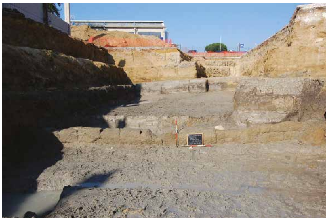
Figura 3.1. Struttura in blocchi di tufo. Prospetto S. Vista da S-SE.
