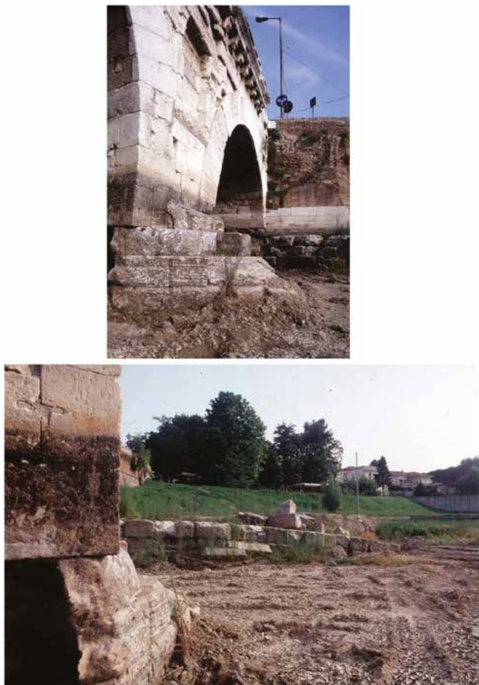
Figura 1. Ponte di Tiberio, i lunghi muri emersi durante lavori di pulizia dell'alveo (Archivio Associazione «Rimini Sparita»).
