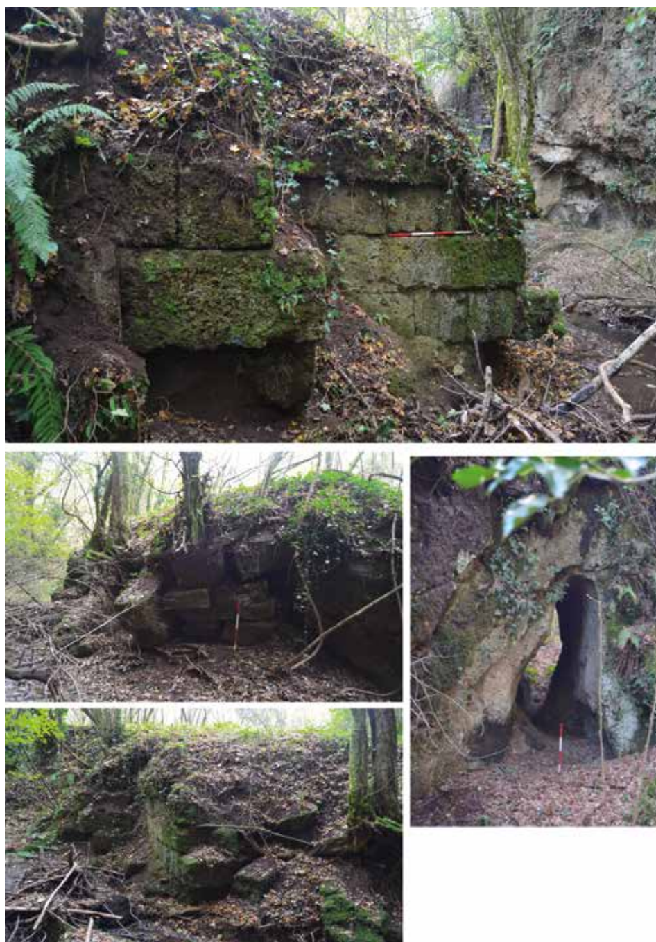
Figura 3. Strutture in opera quadrata lungo il corso del Fosso di Fustignano (tipo 2.1). Figura 3.1. Struttura di sbarramento in opera quadrata con blocchi disposti di testa e di taglio. Prospetto a monte. In primo piano particolare dell'argine settentrionale (cfr. fig. 2, lett. O). Figura 3.2. Particolare del nucleo della struttura a fig. 2, lett. O. Figura 3.3. Particolare della struttura a fig. 2, lett. O e dell'argine settentrionale. Figura 3.4. Canale di deviazione. Cfr. fig. 2, lett. N.
