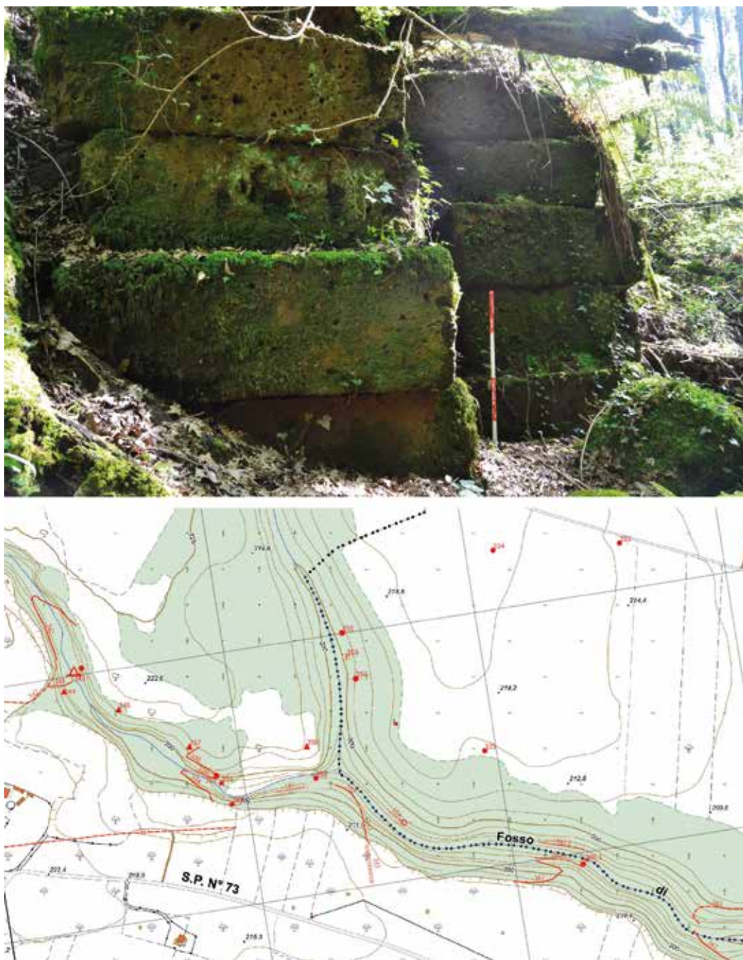
Figura 5. Sistemazioni idriche lungo il Rio della Tenuta (Rizzo c.d.s., tipo 2.2). Figura 5.1. Struttura di sbarramento in opera quadrata con blocchi posti di taglio. Particolare della porzione interna caratterizzata da doppia cortina di blocchi. Figura 5.2. Posizionamento su cartografia CTR 356013 delle evidenze sul Rio della Tenuta (Rizzo c.d.s., nn.° 360-362).
