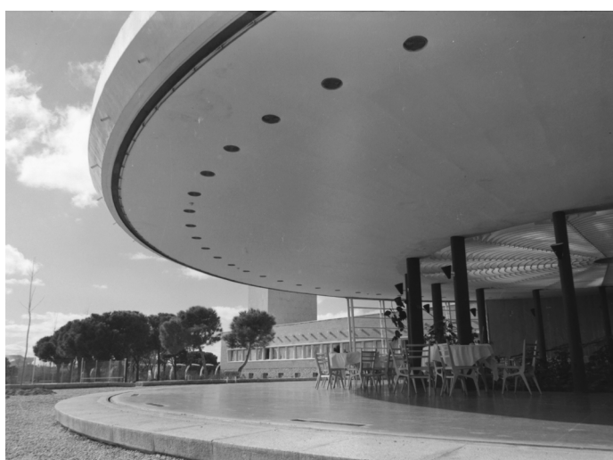
Figura 2.5. Izquierda: Comedor circular con cubierta en voladizo y un cerramiento corredero que permite que este espacio quede al aire libre integrándose sin discontinuidades con su entorno. La cubierta se realizó mediante un sistema de vigas metálicas que, apoyadas en unas columnas dispuestas en forma de anillo en el interior de la sala, vuelan radialmente hasta el borde. Derecha: Vestíbulo de personal en doble altura y rampa de comunicación que permite la continuidad espacial entre las plantas baja y primera. FUENTE: Archivo IETcc.
