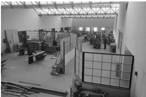
Figura 2.3. Diversas salas del ITCc de la época. Izquierda: Nave de talleres. Es característica su cubierta compuesta por nueve bóvedas cilíndricas realizadas mediante una estructura metálica muy liviana de celosía triangulada, que sostenía una superficie continua de planchas de madera y corcho para su aislamiento térmico y láminas onduladas de zinc como revestimiento. Uno de los requisitos de esta sala era que estuviera bien iluminada, para lo cual se practicaron unos lucernarios con orientación norte, sin radiación solar directa en ninguna época del año. Derecha: Laboratorio de química. FUENTE: Archivo IETcc.
