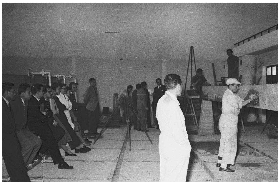
Figura 5.3. Los estudiantes asistiendo a la reparación de una viga de hormigón. FUENTE: Archivo IETcc.
