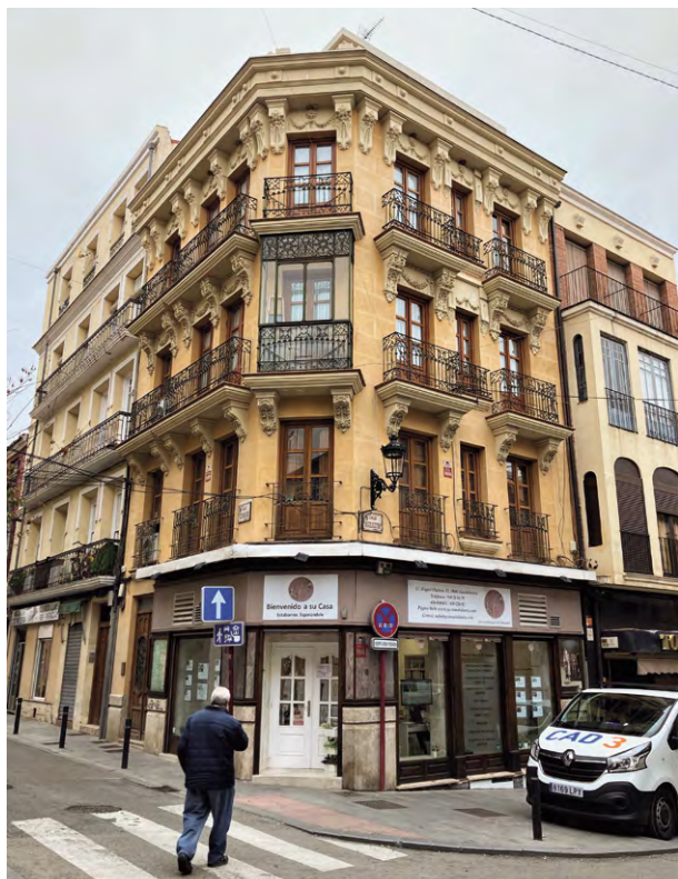
Figura 4.67. Edificio en calle de la Cruz Verde y calle Mayor Baja. Foto: autor.
