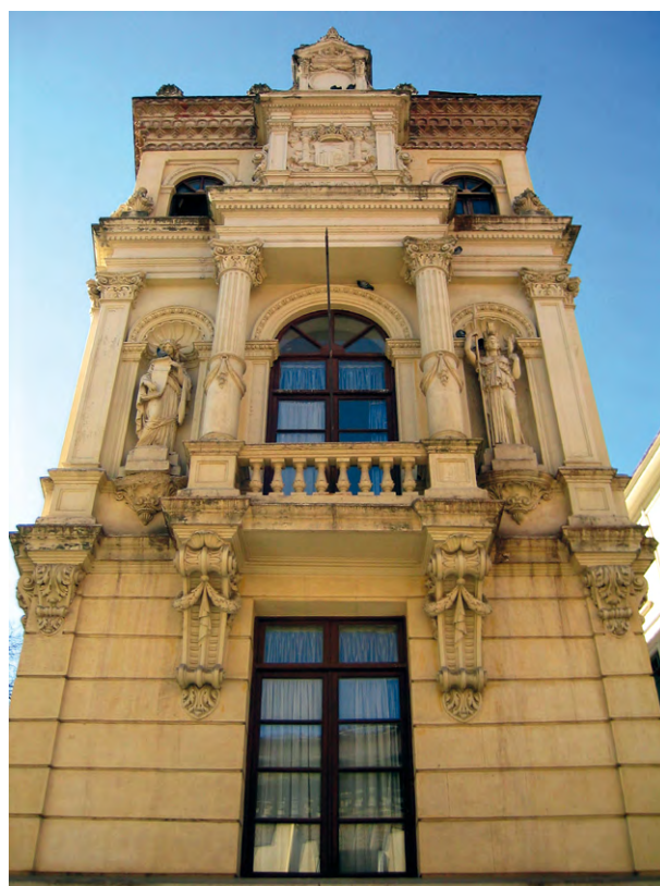
Figura 4.54. Instituto de Guadalajara. Alzado a calle Teniente Figueroa. Fotografía: autor.
