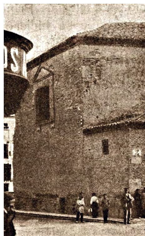
Figura 4.15. Coro del convento de Santa Clara. Fachada a la calle Mayor Baja. Foto: autor desconocido [26].
