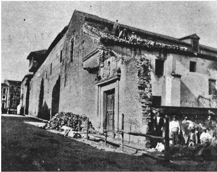
Figura 4.18. Portada del convento de Santa Clara durante los trabajos de demolición. Foto: Ángel Arquer.
