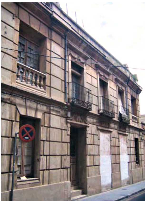
Figura 4.72. Fachada demolida. Calle del Museo, 3. Foto: B. González y C. López.
