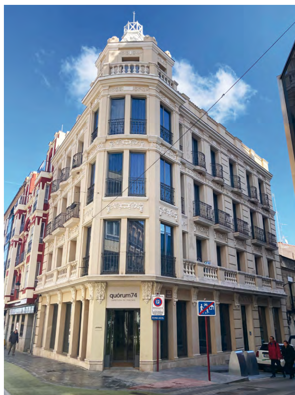
Figura 4.45. Casa número 1 de la calle Francisco Cuesta. Estado actual. Foto: autor.
