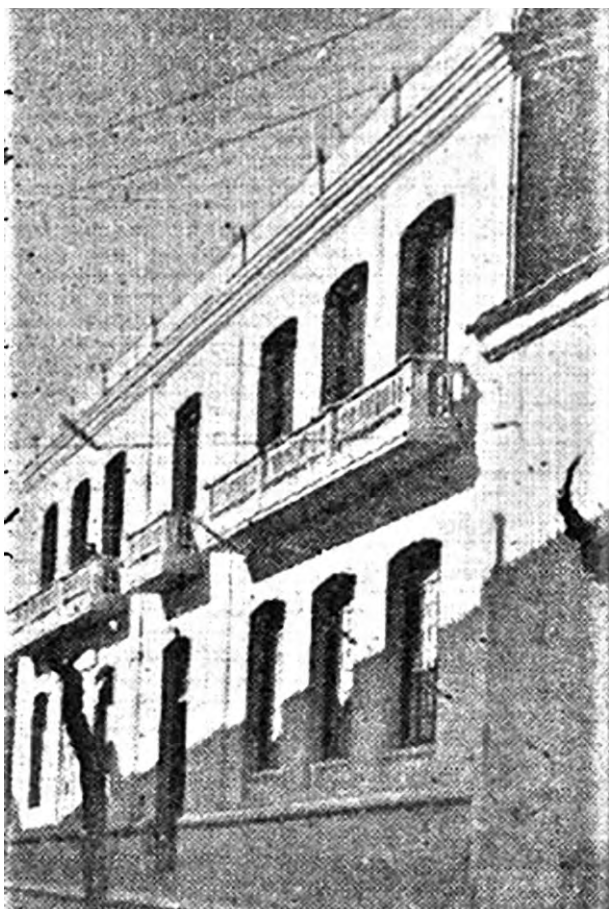
Figura 4.190. Fachada de Educación y Descanso, antiguo Ateneo Obrero. Foto: autor desconocido.
