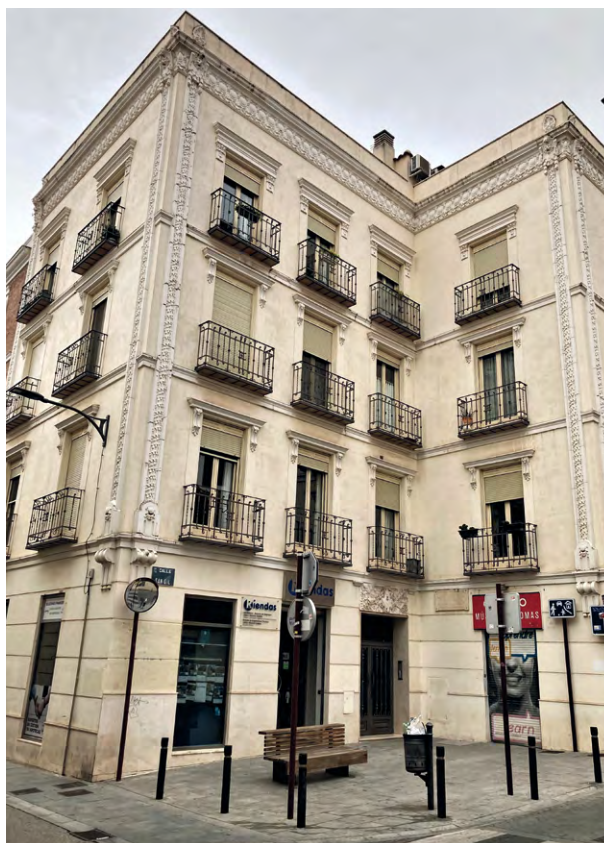
Figura 4.80. Reproducción de la fachada en el nuevo edificio. Foto: autor.
