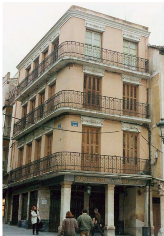
Figura 4.150. Edificio calle Mayor alta, 2, esquina con la plaza Mayor. Foto: autor.
