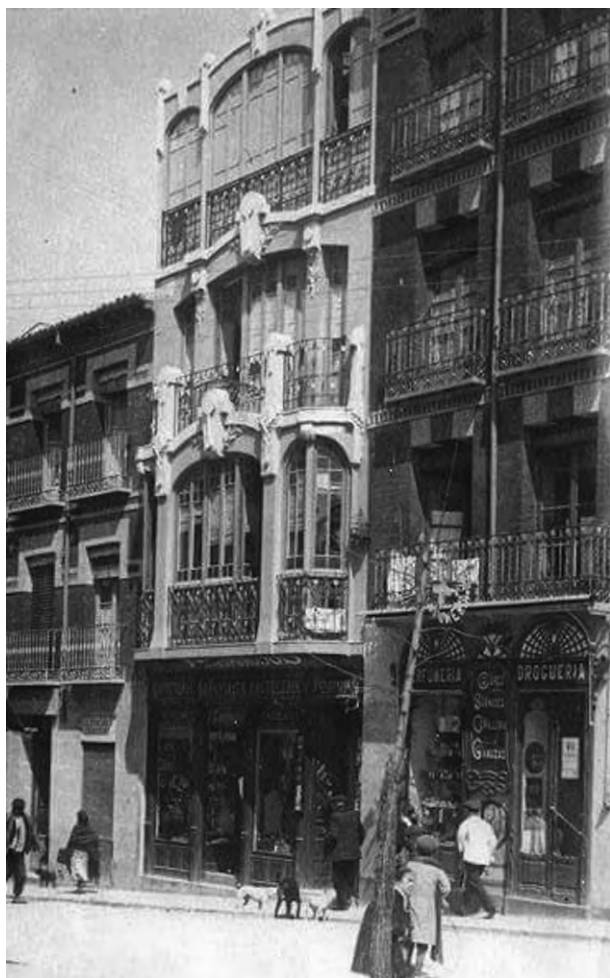
Figura 4.48. Edificio en los números 4 y 6 de la calle Mayor Baja. Fotografía: autor desconocido.
