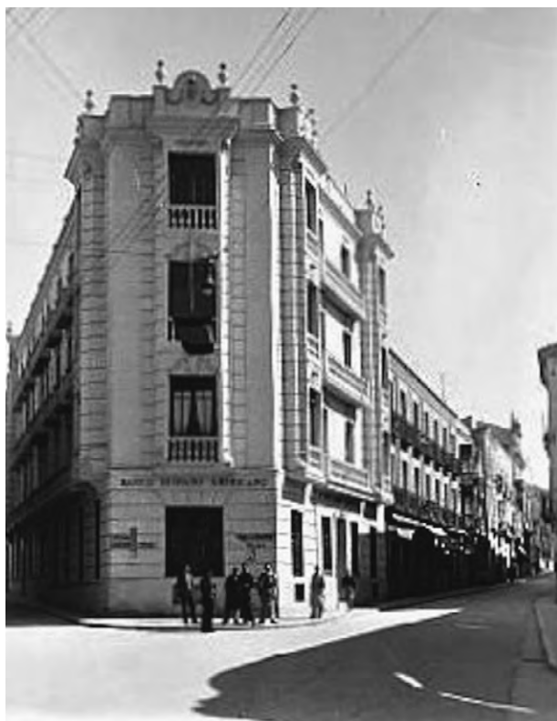
Figura 4.177. Edificio calle Topete, 2. Fachada a plaza de Don Diego. Fotografía: autor desconocido.
