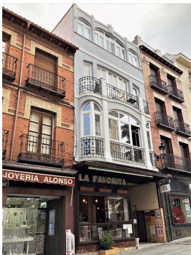
Figura 4.49. Edificio en los números 4 y 6 de la calle Mayor Baja. Estado actual. Fotografía: autor.
