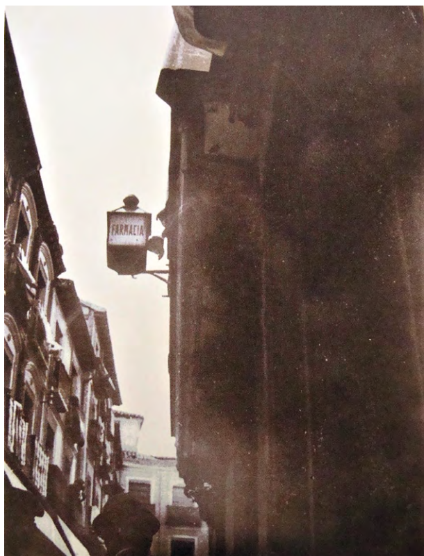
Figura 4.5. Fotografía del primer tramo de la calle Mayor Baja. Foto: autor desconocido.
