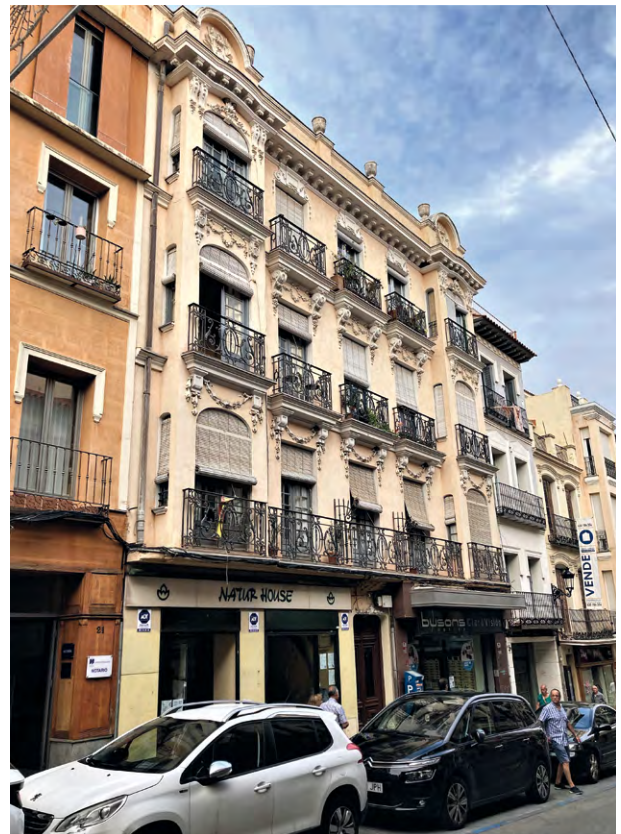
Figura 4.40. Edificio en calle mayor Baja, 25-31. Foto: autor.
