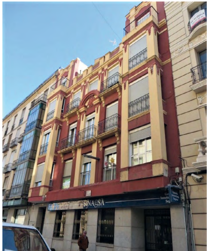
Figura 4.42. Edificio en calle mayor Baja, 30. Foto: autor.
