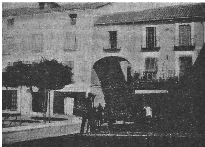
Figura 4.13. Arco en la plaza Mayor de la que partía la calle Mayor Baja. Foto: autor desconocido.
