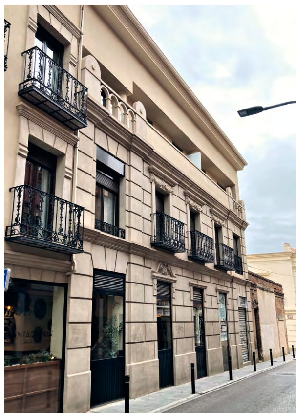
Figura 4.73. Nueva fachada del edificio de calle del Museo, 3. Foto: autor.
