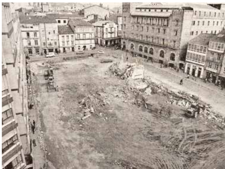
Figura 64. La plaza de Galicia inmediatamente después de la demolición.
