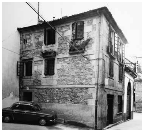
Figura 55. Misma fachada después de la retirada del revoco.
