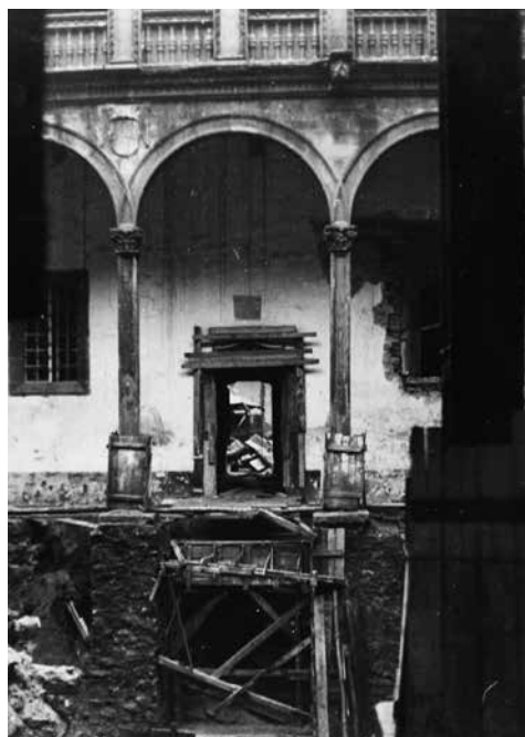
Figura 46. Excavación y forjado de viguetas en el claustro renacentista del Hostal. Año 1964.
