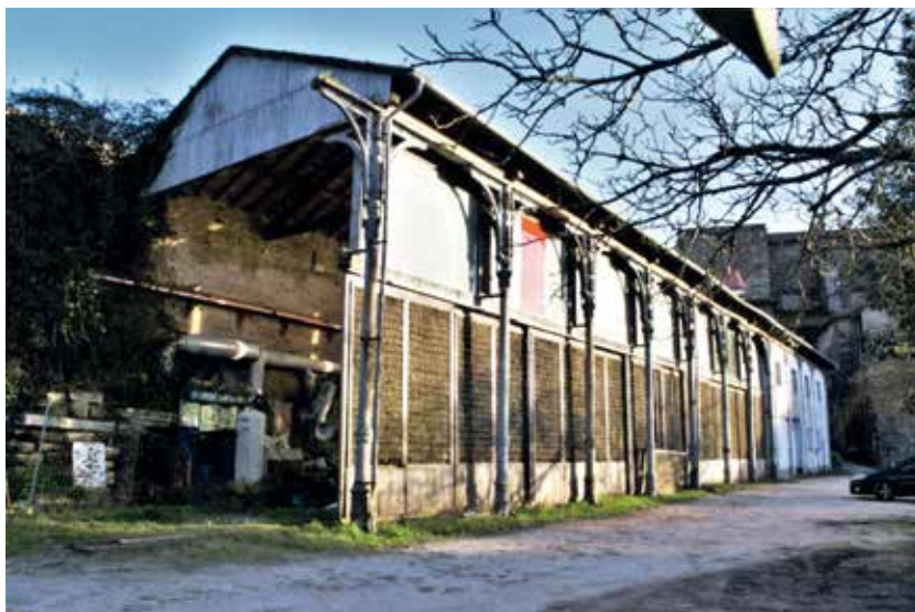
Figura 12. Fotografía del Pabellón historicista antes de su rehabilitación. Fotografía Iago Seara y Juan Orozco.
