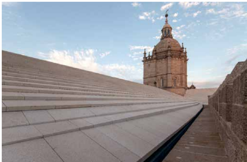
Figura 10. Evocación del paseo de ronda que va desde la sala de guardia hacia el cimborrio, para luego girar en el área de la torre octogonal a mano derecha, continuando hacia el sur y finalmente llegar a la cubierta plana de la tribuna sur. A su derecha el almenado. (Fotografía Denis Estévez).
