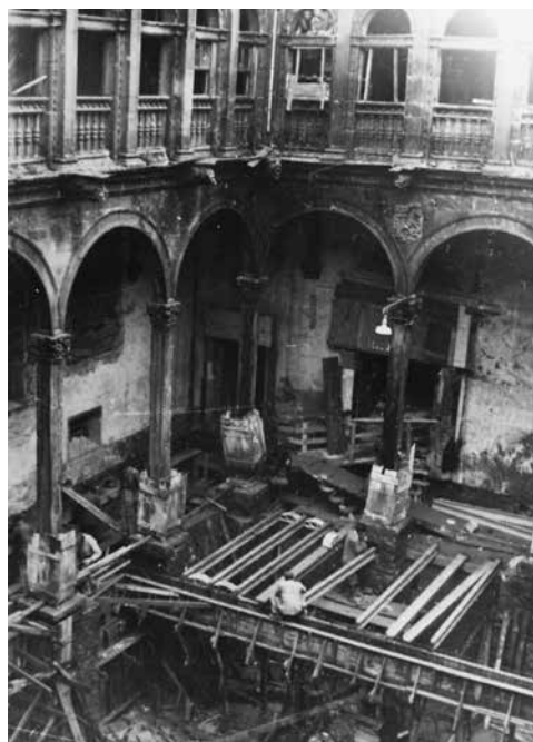
Figura 45. Excavación y forjado de viguetas en el claustro renacentista del Hostal. Año 1964.
