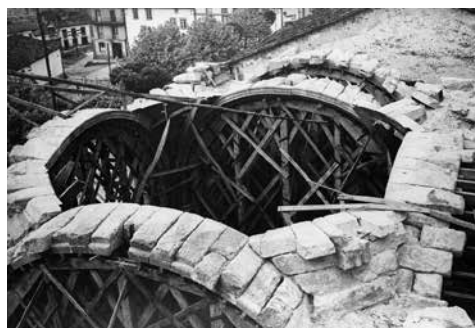
Figura 48. Reconstrucción de la iglesia del Pilar. Encimbrado ligneo de arcos. Año 1957.
