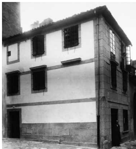
Figura 54. Fachada en San Paio de Antealtares con el revoco de cal.
