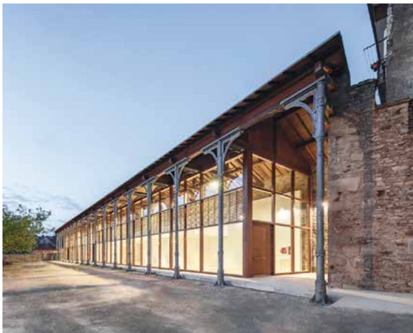
Figura 13. Fotografía del Pabellón Historicista una vez restaurado y rehabilitado (2024). Fotografía Denis Estévez.
