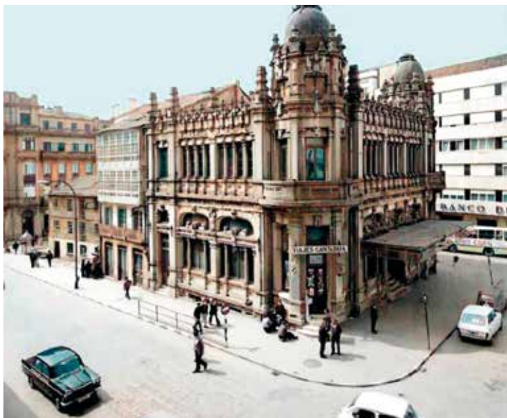
Figura 63. Edificio Castromil. Rafael González Villar. Años 1926-1975.
