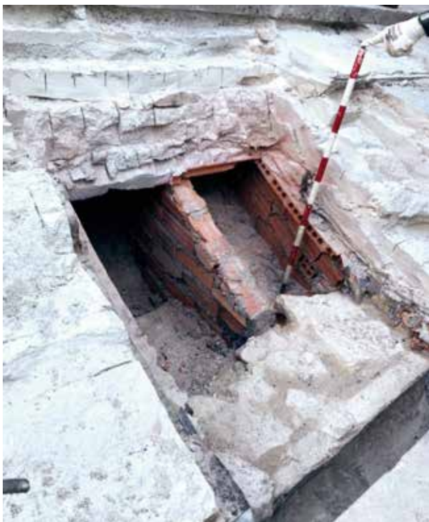
Figura 8. Fotografía de la cata constructiva nº18, con control arqueológico, en la proximidad del encuentro del faldón sur de la nave principal con la limahoya de encuentro con el faldón occidental del transepto sur y el canal perimetral. Se observa el sistema implementado por Pons-Sorolla de tabiques de ladrillo y tablero de rasillón y el superpuesto por Baltar, Bartolomé y Almuiña del que no se tenía constancia. (Fotografía Iago Seara – Juan Orozco)
