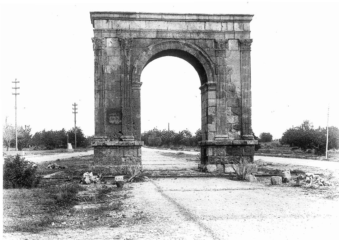
FIGURA 50. El monument, un cop finalitzada la restauració realitzada per la Generalitat de Catalunya el 1936 (Fons documental del Servei del Patrimoni Arquitectònic Local de la Diputació de Barcelona, clixé núm.: 32.790).
