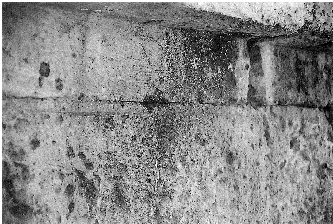
FIGURA 61. Restes de l' anathyrosis externa encara visible en els blocs del cos central del podi (fotografia Martín García).
