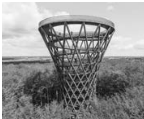
Figura 1.33. Izquierda: depósito de agua en Fedala, Marruecos, Eduardo Torroja, 1956. La estructura consta de dos hiperboloides hiperbólicos unidos por su círculo de garganta y bóvedas anulares de directriz parabólica (Torroja, E., 1962a). Centro: mirador Treetop, Copenhague, Denmark, EFFEKT Studio, 2018. Este elemento es un hiperboloide hiperbólico representado por sus generatrices y directrices. En su interior se incluye una rampa helicoidal que se adapta a la forma de la hipérbola (Caliò, Marchetti, 2019). Derecha: Hélices contenidas en un hiperboloide de una hoja.
