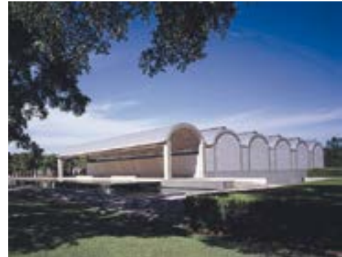
Figura 1.16. Izquierda: curva cicloide r = 1 . Descrita por un punto de una circunferencia al rodar. Imagen de los autores. Derecha: Museo Kimbell, Fort Worth, Texas, Louis Kahn, 1972. Las cubiertas siguen la forma de la curva cicloide. De Carol M. Highsmith. Dominio público, https://commons.wikimedia.org/w/index.php?curid=31402682 .
