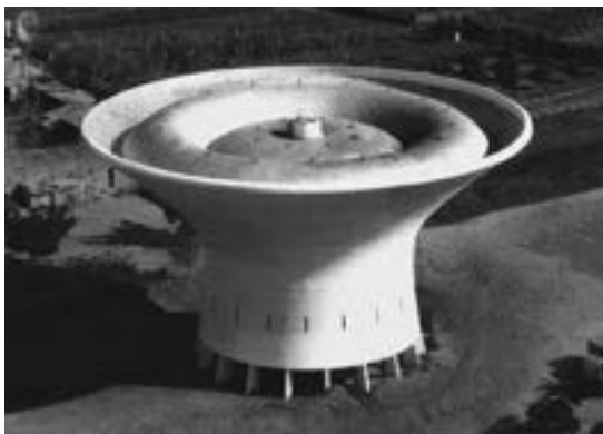
Figura 1.33. Izquierda: depósito de agua en Fedala, Marruecos, Eduardo Torroja, 1956. La estructura consta de dos hiperboloides hiperbólicos unidos por su círculo de garganta y bóvedas anulares de directriz parabólica (Torroja, E., 1962a). Centro: mirador Treetop, Copenhague, Denmark, EFFEKT Studio, 2018. Este elemento es un hiperboloide hiperbólico representado por sus generatrices y directrices. En su interior se incluye una rampa helicoidal que se adapta a la forma de la hipérbola (Caliò, Marchetti, 2019). Derecha: Hélices contenidas en un hiperboloide de una hoja.
