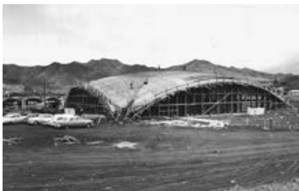
Figura 1.45. Izquierda: Windward City Foodland, Keneohe, Hawaii, UU. EE., J. Joedicke, 1958 (Joedicke, 1964). La cubierta es una bóveda por arista bitórica, cubre una planta cuadrada de 39 metros de lado y su espesor varía desde 8 cm en el centro hasta los 18 cm. Derecha: representación del edificio toroidal en Keneohe. Representación Geogebra.
