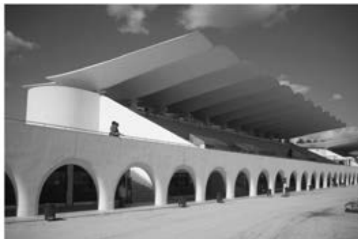
Figura 1.32. Izquierda: hiperboloide hiperbólico. Derecha: tribuna del Hipódromo de la Zarzuela, Madrid, Eduardo Torroja, 1935. Esta obra incorpora los hiperboloides hiperbólicos en las láminas voladas de la cubierta, mientras que las gradas se apoyan en bóvedas tóricas (Torroja, E., 1962b) (Moragues et al., 2015) (Martínez, I., Castillo, 2018).
