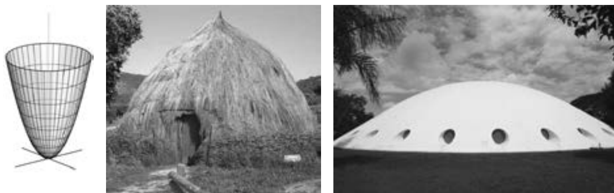
Figura 1.35. Izquierda: Paraboloide elíptico. Centro: Chozo de ramas en la Codosera, Badajoz. De Berrocal http://joseluisolmoberrocal.blogspot.com/2013/02/los-chozos.html . Esta estructura se construye para albergar a pastores en sus estancias en el campo. Se suele utilizar para ello ramas de encina recubiertas con retamas. La forma curva de las ramas se aproxima a la del paraboloide elíptico, arrancando con una curvatura más abierta, para redondearse en la mitad superior. El acabado en punta desdibuja un tanto su semejanza. Derecha: pabellón en el Parque de Ibirapuera, Sao Paulo, Oscar Niemeyer, 1954. Es una cúpula de hormigón de sección parabólica.
