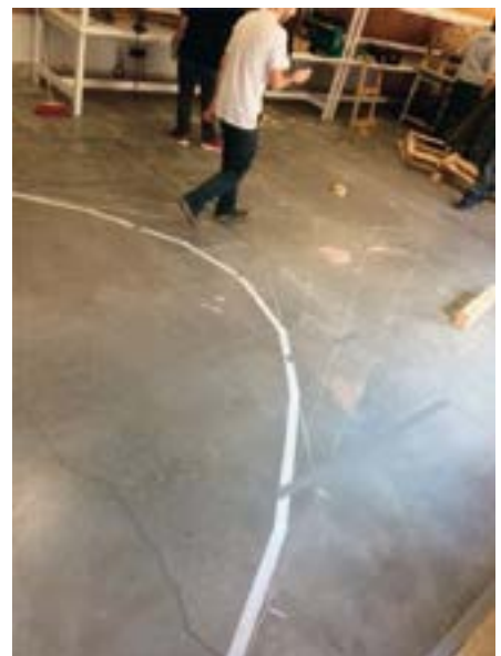
Figura 1.2. Semana de la Arquitectura UAH. 2015. Taller de arquitectura textil y de carpintería. Replanteo a tiza sobre el suelo de curvas cónicas, elipse (izquierda) y parábola (derecha). Imagen de los autores.
