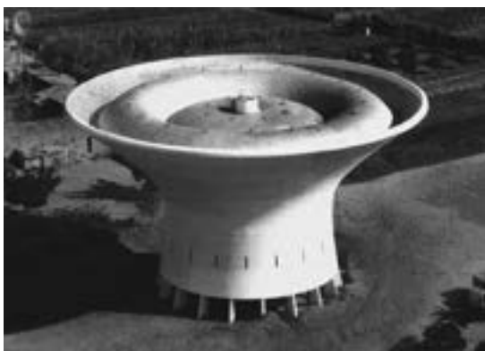
Figura 1.33. Izquierda: depósito de agua en Fedala, Marruecos, Eduardo Torroja, 1956. La estructura consta de dos hiperboloides hiperbólicos unidos por su círculo de garganta y bóvedas anulares de directriz parabólica (Torroja, E., 1962a). Centro: mirador Treetop, Copenhague, Denmark, EFFEKT Studio, 2018. Este elemento es un hiperboloide hiperbólico representado por sus generatrices y directrices. En su interior se incluye una rampa helicoidal que se adapta a la forma de la hipérbola (Caliò, Marchetti, 2019). Derecha: Hélices contenidas en un hiperboloide de una hoja.
