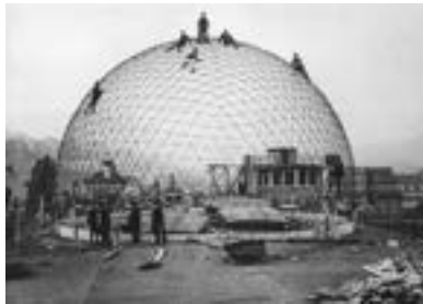
Figura 1.24. Izquierda: Primer Goetheanum, Rudolf Steiner, 1914. Fotografía de la cimbra. La cubierta muestra dos esferas en madera, cuya intersección es una circunferencia (Kiuntzli et al., 2020). Centro: Planetario Zeiss de Jena, Franz Dischinger, 1926. Fotografía de la armadura de la lámina de hormigón. La disposición de las barras forma una cúpula geodésica (Hines, 2004). Derecha: Mercado de Algeciras, Eduardo Torroja, 1933. Cubierta formada por un casquete esférico y lunetos cilíndricos de eje horizontal (Torroja, E., 1962c).
