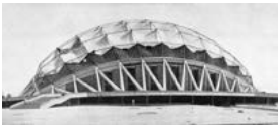
Figura 1.25. Izquierda: Palacio de los Deportes, Félix Candela, 1968. De una superficie esférica se toman meridianos en dos direcciones que se cierran con hiperboloides hiperbólicos (Candela Outeriño, Peyri Macía y Castañeda Tamborrell, 1968). Derecha: Comparativa de la evolución de la forma de las cubiertas de la Ópera de Sydney, 1973 (Rey-Rey, 2014). Las cubiertas están concebidas como triángulos esféricos, aunque no funcionan como una cáscara, sino como la suma de nervios en abanico.
