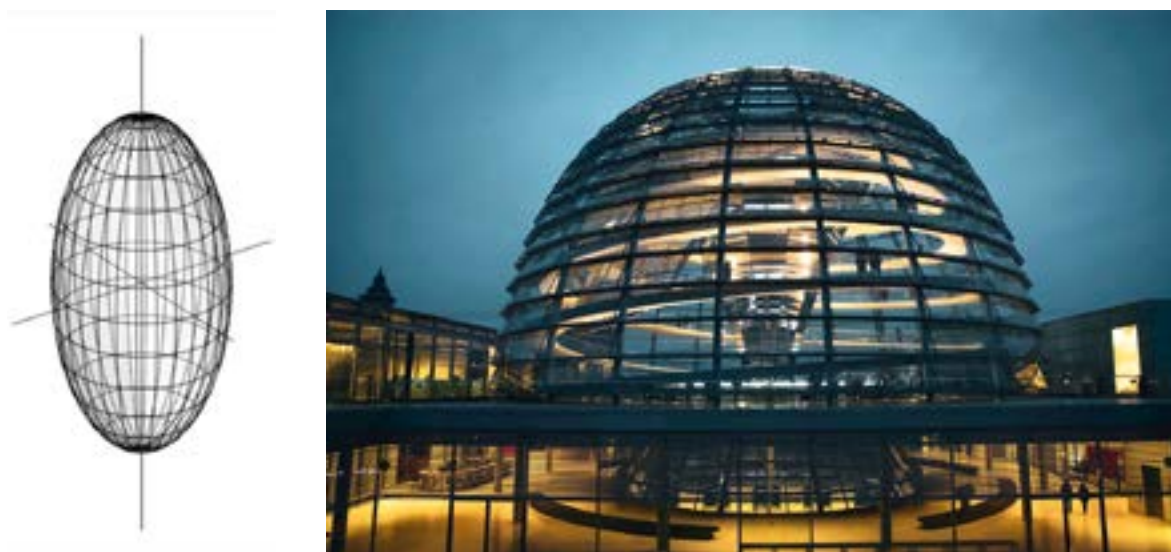
Figura 1.21. Izquierda: Elipsoide. Derecha: Cúpula del Reichstag, Norman Foster, 1999 (imagen de Christian Lue, https://unsplash.com/es/fotos/seWsl9kjkW8 , Licencia Unsplash). Es una estructura metálica cuyos meridianos tienen forma elíptica, que se unen en un anillo en la parte superior.
