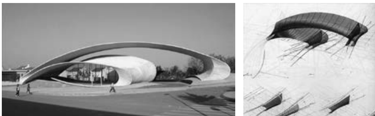
Figura 1.34. Estación de autobuses, El Casar de Cáceres, Justo García Rubio, 2004. Las láminas de hormigón combinan hiperboloides de diferentes radios.
