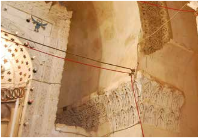
Fig. 13. Archivolt and cornice of the apse of the Church of Mor Simeon at Habsenas.
