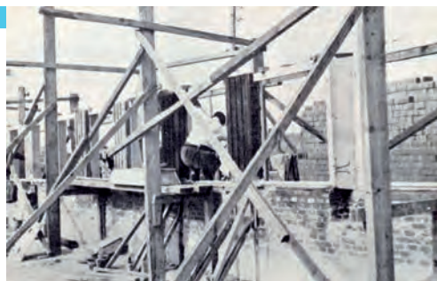
Fig. 21: Proceso de colocación y recibido de cercos de ventanas prefabricados
