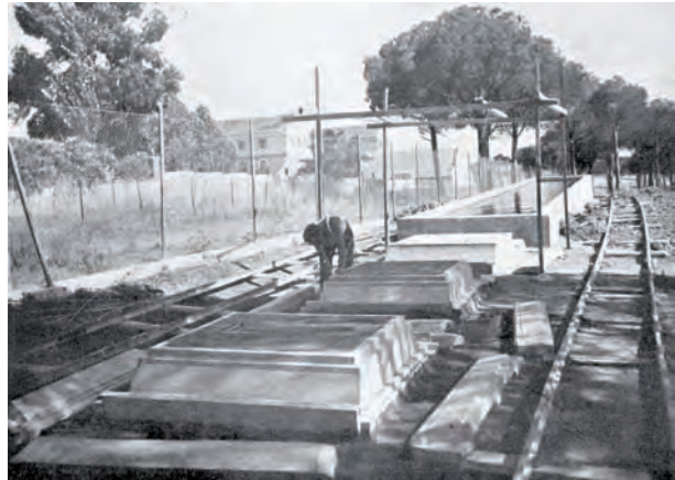
Fig. 19: Prefabricación de cercos de ventanas/ Precasting of window frames
