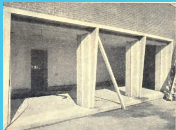
Fig. 31: Prefabricación pórticos de acceso/ Precasting portal frames for entrances
