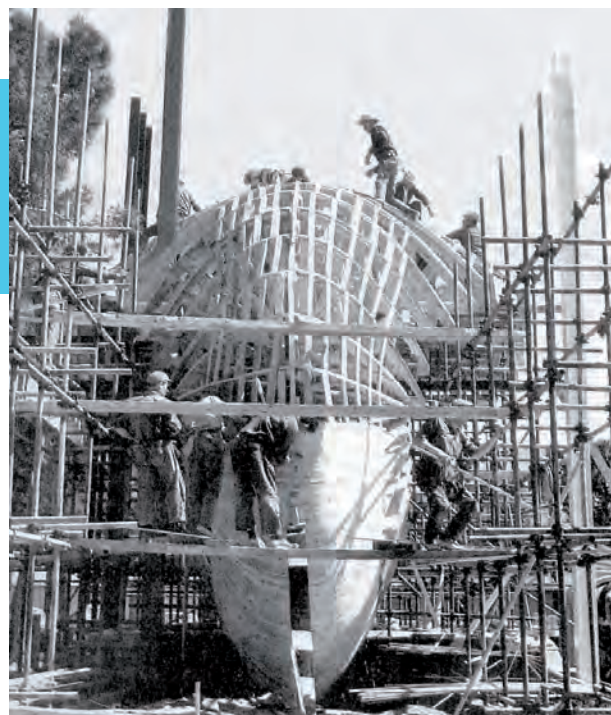
Fig. 45: Ejecución del encofrado / Building the formwork
