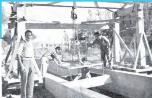
Fig. 20: Cercos de ventanas prefabricados en hormigón armado
