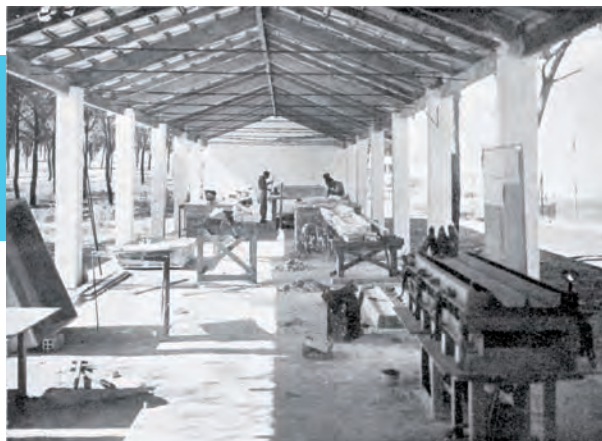
Fig. 17: Taller de prefabricación de elementos / Shop for precasting elements IETcc, 1952
