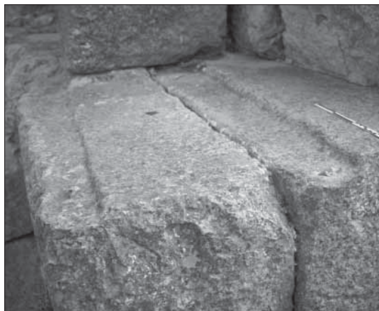
Fig. 7. Stéréobate: préparation des lits d'attente, décrochements d'assises (cl. S. Binninger).
