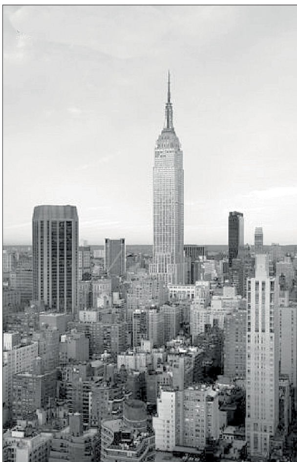
Fig. 32. Empire State Building. Nel 1945 un caccia bombardiere B 25 con 10 tonnellate di carburante a bordo, si è schiantato a causa della nebbia contro il 79° piano dell'Empire. La struttura portante del grattacielo, di pietra calcarea, mattoni ed acciaio, e le relativamente basse temperature sviluppate dal tipo di combustibile dell'aereo in esplosione hanno permesso di ridurre i danni ad uno squarcio di 6 x 6 mq; solo 14 persone sono morte e 26 sono rimaste ferite.
