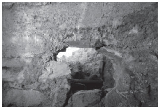
Fig. 16. Place Triangulaire. Percement de la voûte du collecteur E XI lié au passage de la conduite M 15. (L. Brissaud).
