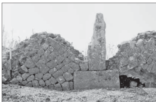
Fig. 28. Dintorni di Dougga, sito 508, fattoria: muro perimetrale in opus africanum con specchi in opus reticulatum.
