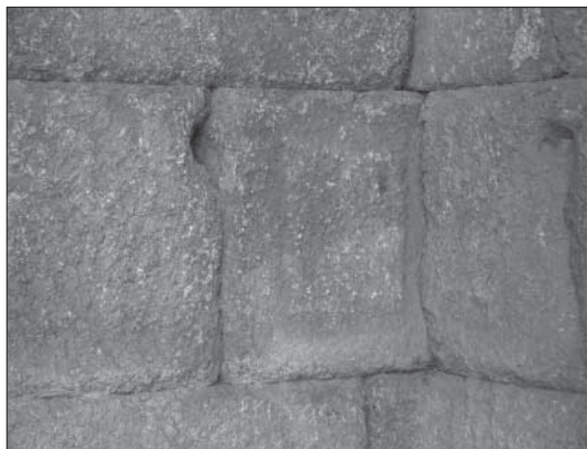
Fig. 12. Resti del bugnato su una delle superfici dei blocchi in granito dell' "arco di Traiano".
