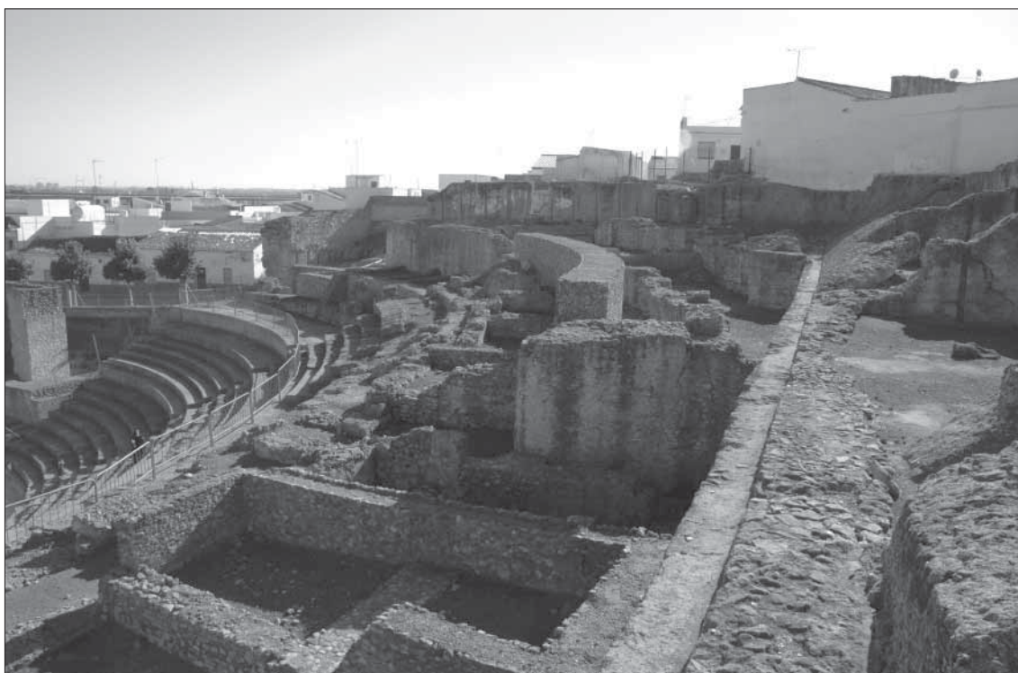
Fig. 6. Estructura curva en opus caementicium con ángulos macizos reforzados, levantada en la parte alta de la cavea teatral.
