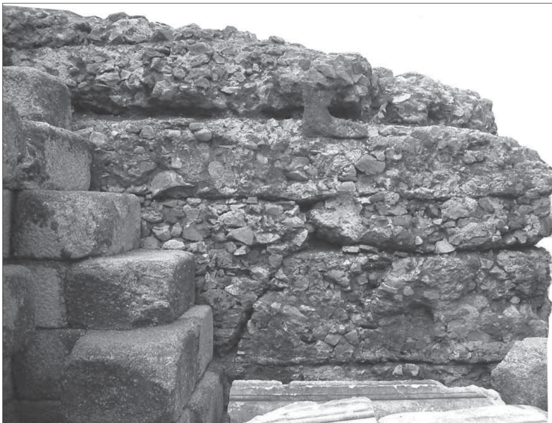
Fig. 18. Fasi di cantiere nella costruzione della parte in opus caementicium del podio del tempio.
