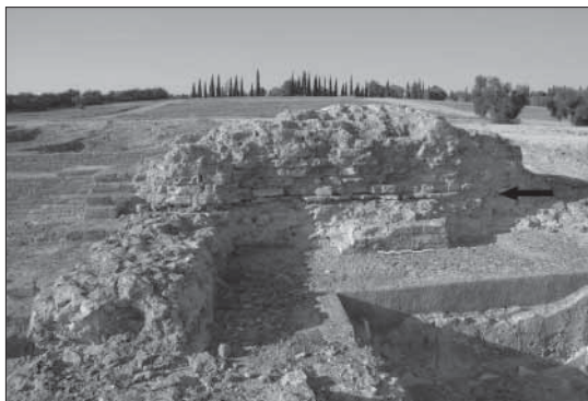
Fig. 12. Termas Mayores. Espace 13, mur nord, parement sud : réfection avec fines bipedales (cliché HD).
