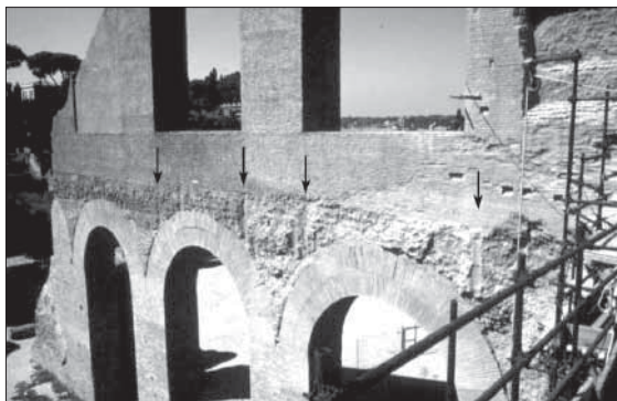
Fig. 29. Basilica di Massenzio, lato est. Serie di impronte lasciate dai tubi di cantiere sulla verticale dei muri di alzato e lungo lo spiccatto della teoria di crociere.
