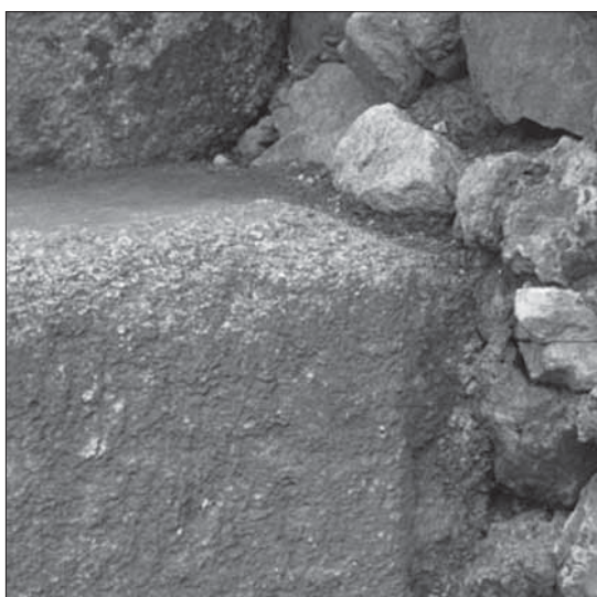
Fig. 19. Particolare del punto di contatto tra il blocco di granito del paramento e il nucleo in opus caementicium del podio del tempio.
