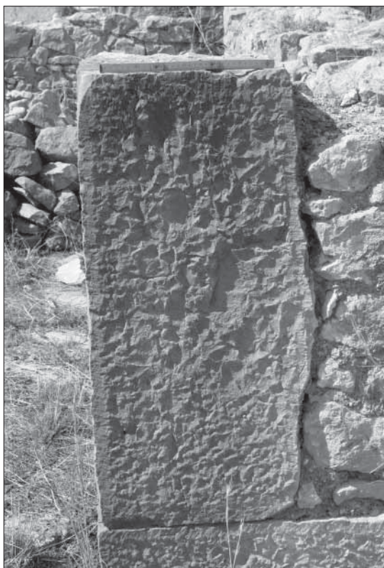
Fig. 6. Blocco in calcare compatto in uno degli stipiti della casa.
