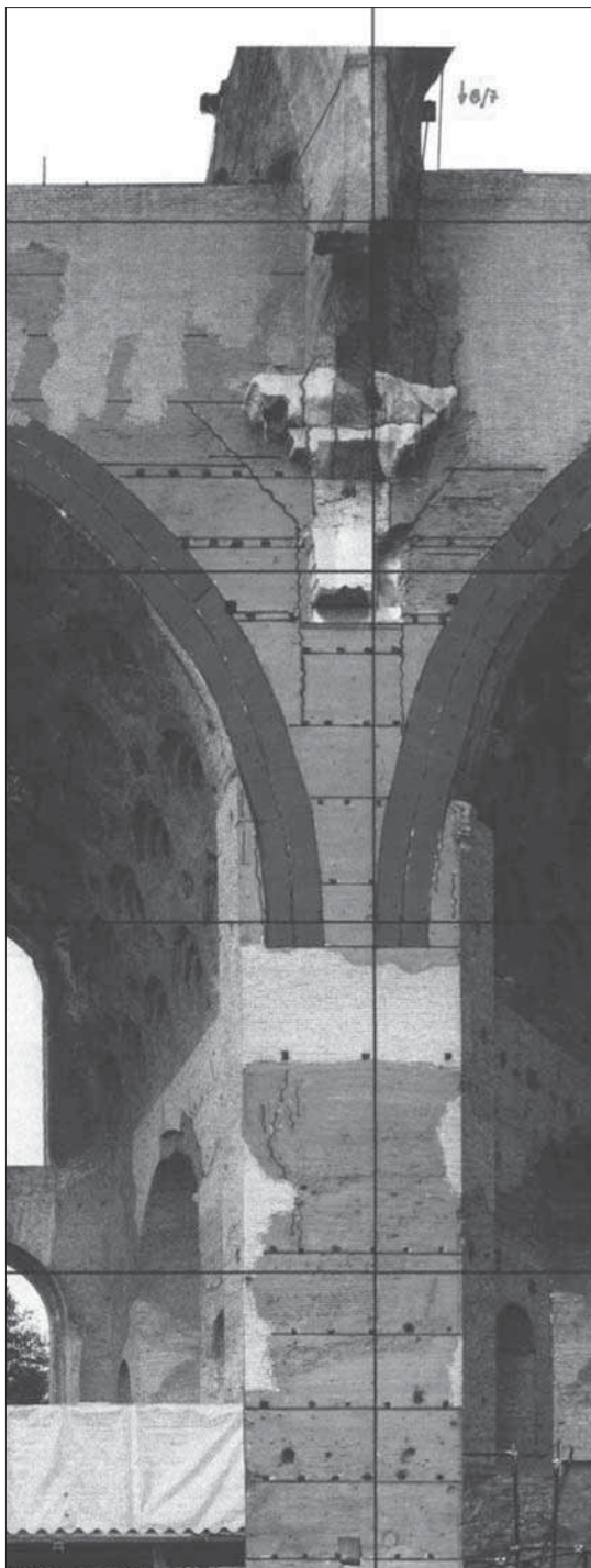
Fig. 14. Basilica di Massenzio, testata del muro di sostegno di una coppia di volte a botte, a cui andava addossata una delle colonne relative alle crociere di copertura della navata centrale: staticamente l'elemento nodale nella progettazione del sistema di copertura.
