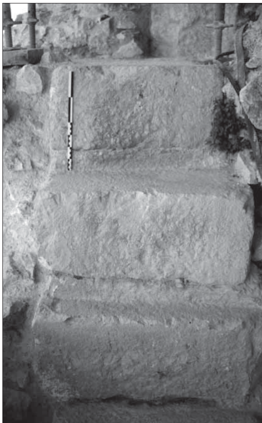
Fig. 6. Mur courant du cylindre : préparation des lits d'attente, décrochement d'assises (cl. S. Binninger).
