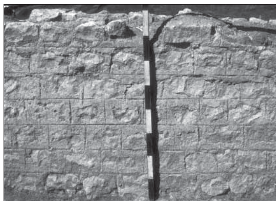
Fig. 10. Premier théâtre (état 1a). Appareil à moellons quadrangulaires avec joints au fer.
