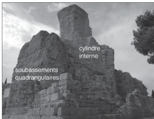
Fig. 2. Etat actuel. L'arrière peu affecté par les restaurations : cylindre interne et élévation orientale des soubassements quadrangulaires. Vue depuis le nord-est (cl. S. Binneringer).
