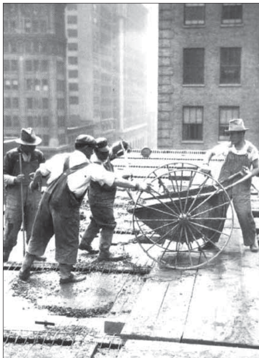
Fig. 17. Empire State Building, gettata di calcestruzzo in corrispondenza dell'arretramento del 5° piano. La capacità delle carriole per il calcestruzzo è di sei piedi cubi, una quantità sufficiente a produrre da 3,5 a 4,5 mq di pavimentazione. Gli operai provvedono a spargere il calcestruzzo con i piedi e a distribuirlo per evitare che il cemento risalga verso la superficie della gettata e che gli inerti si depositino sul fondo.
