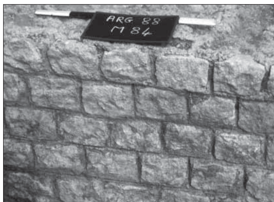
Fig. 11. Second théâtre. Appareil à moellons quadrangulaires avec joints au fer.
