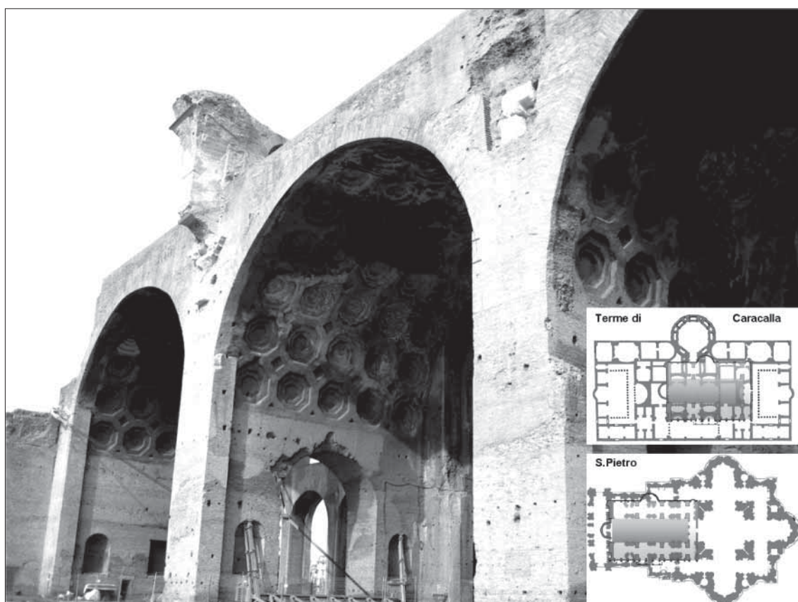
Fig. 33. Basilica di Massenzio. Nei riquadri, proiezione dell'ingombro delle volte della navata centrale della Basilica sugli schemi planimetrici delle Terme di Caracalla e della Basilica di S. Pietro a Roma, per evidenziarne i reciproci rapporti dimensionali.
