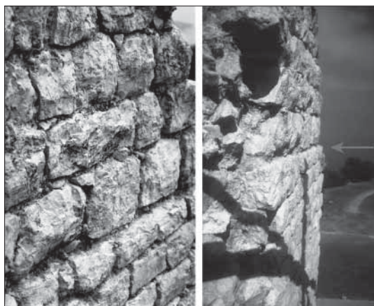
Fig. 11. Opus vittatum à l'angle sud-est du soubassement quadrangulaire interne oriental, vue depuis l'ouest (cl. S. Binninger).
