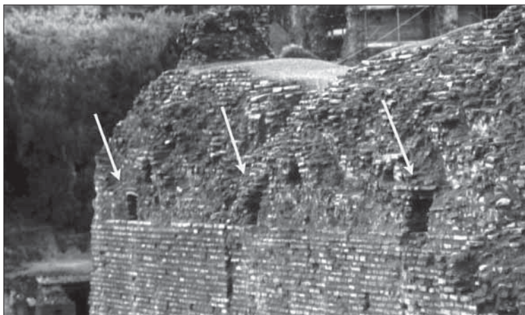
Fig. 31. Basilica di Massenzio, muro perimetrale sud ovest, lato interno. Visibili le aperture a sezione rettangolare lasciate in corso d'opera sulla linea d'imposta della volta, evidenziata dal marcapiano di bipedali. Gli incassi soprastanti, che fornivano appoggio alle travi orizzontali della centina, sono stati rilavorati come elementi triangolari del cassettonato.
