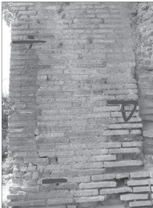
Fig. 16. Amb. 27-3, parete sud: SR-005, 6 e 14. Lo spigolo è stato integrato nel '900.
