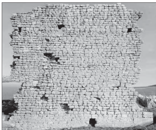
Fig. 30a. Dintorni di Dougga, sito 205, fattoria: facciata esterna ovest in opus vittatum con cantoni di grandi blocchi squadri.
