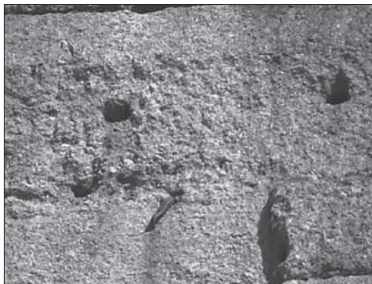
Fig. 16. Particolare dei fori e le grappe per collocare l'imposta dell'arco.
