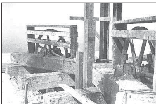
Fig. 11. Empire State Building . Pulegge a gola da 48 pollici di due montacarichi, circondate da una incastellatura di legno ed acciaio, con le stesse funzioni di un locale macchine permanente, ma di concezione molto più semplice.
