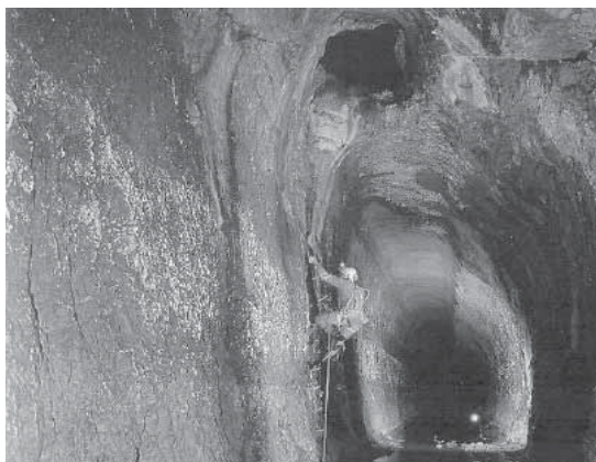
Fig. 8. La Galleria Torlonia in corrispondenza del Monte Salviano; in alto si osserva il cielo dell'emissario antico e lo sbocco di un pozzo (da Burri 1994).
