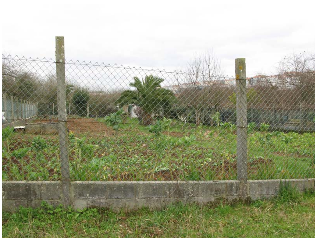
Figura 51. Detalle dun peche feito con formigón e rede metálica para delimitar unha horta á beira do río Sar.
