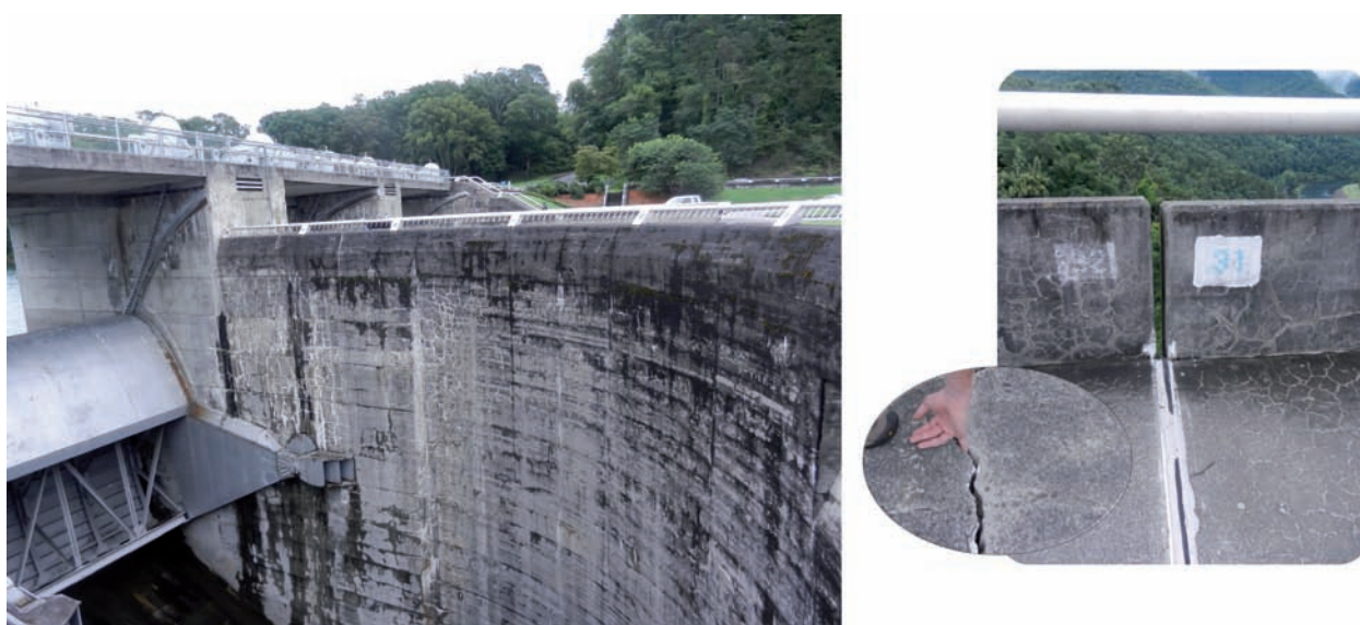
Figura 4. Fisuración, desalineaciones y formación de grietas en la Presa de Fontana (Estados Unidos).
