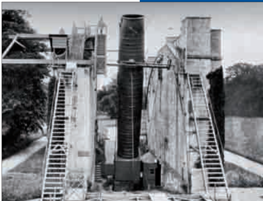
Figura 49.4. Leviatán. El telescopio reflector de 183 centímetros construido por Lord Rosse en 1845. Fuente: King H.C (1995).
